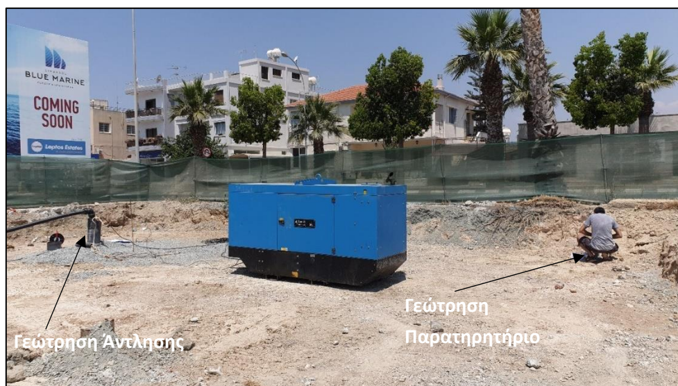
Φωτογραφία 5: Διαμόρφωση της 2 ης Δοκιμαστικής Άντλησης στην περιοχή Α0
