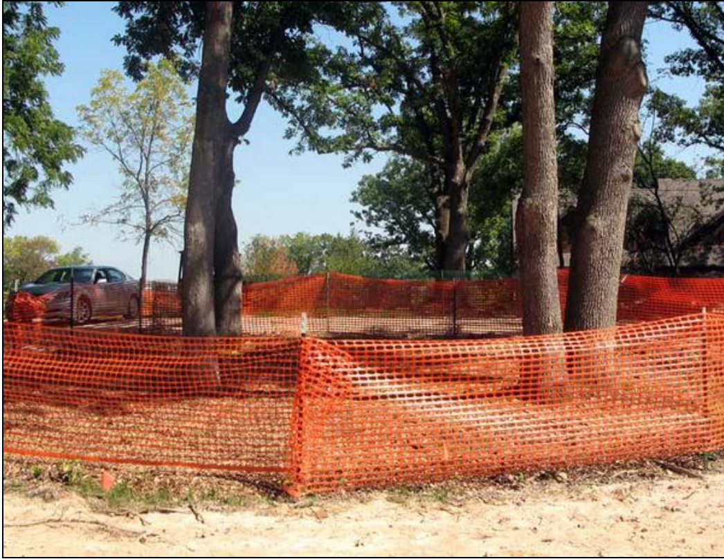
Εικόνα 8-4: Παράδειγμα περίφραξης δέντρων για προστασία
