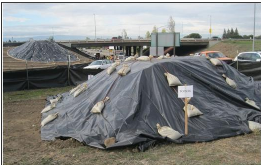
Εικόνα 8-2: Παράδειγμα διάταξης χώρου αποθήκευσης μπαζών/άμμου
