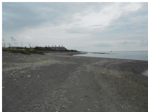
Θέα επί της παραλίας προς ανατολάς-Σταθμός ΑΗΚ στο βάθος
