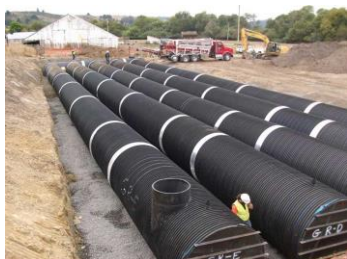
Παραδείγματα υπόγειων δεξαμενών όμβριων νερών, υπό κατασκευή
