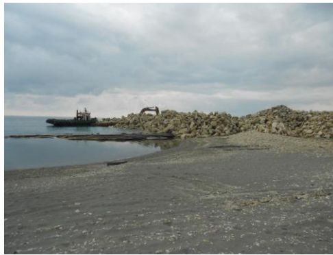
Ο υπό κατασκευή μόλος στα δυτικά
