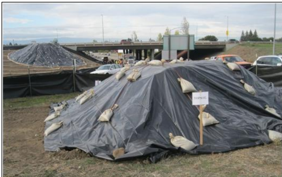
Εικόνα 8-2: Παράδειγμα διάταξης χώρου αποθήκευσης μπαζών/άμμου
