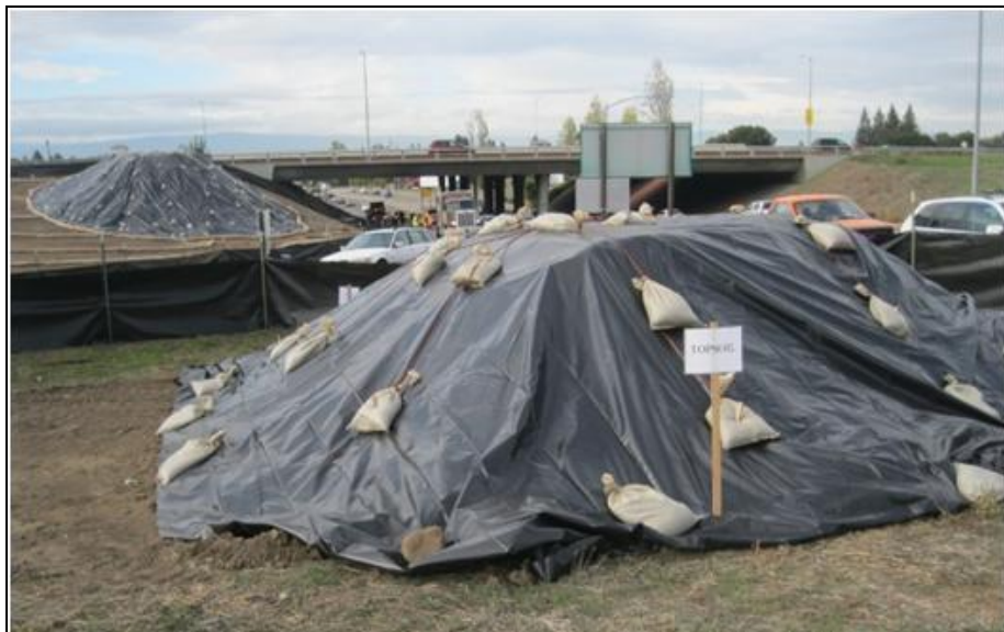
Εικόνα 8-2: Παράδειγμα διάταξης χώρου αποθήκευσης μπαζών/άμμου
