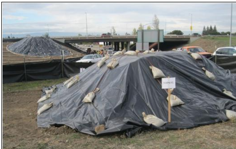
Εικόνα 8-2: Παράδειγμα διάταξης χώρου αποθήκευσης μπαζών/άμμου
