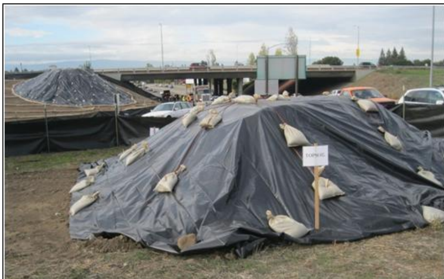
Εικόνα 8-2: Παράδειγμα διάταξης χώρου αποθήκευσης μπαζών/άμμου
