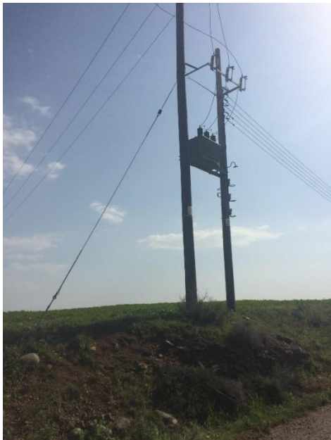
Φωτογραφία 2.2.5: Παροχή Μέσης τάσης πλησίον του τεμαχίου
