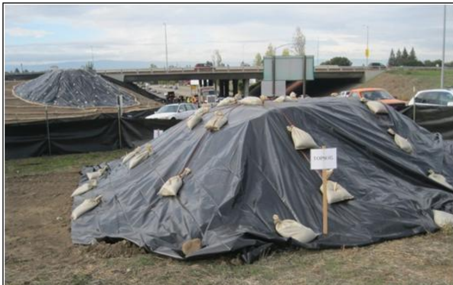
Εικόνα 8-2: Παράδειγμα διάταξης χώρου αποθήκευσης μπαζών/άμμου
