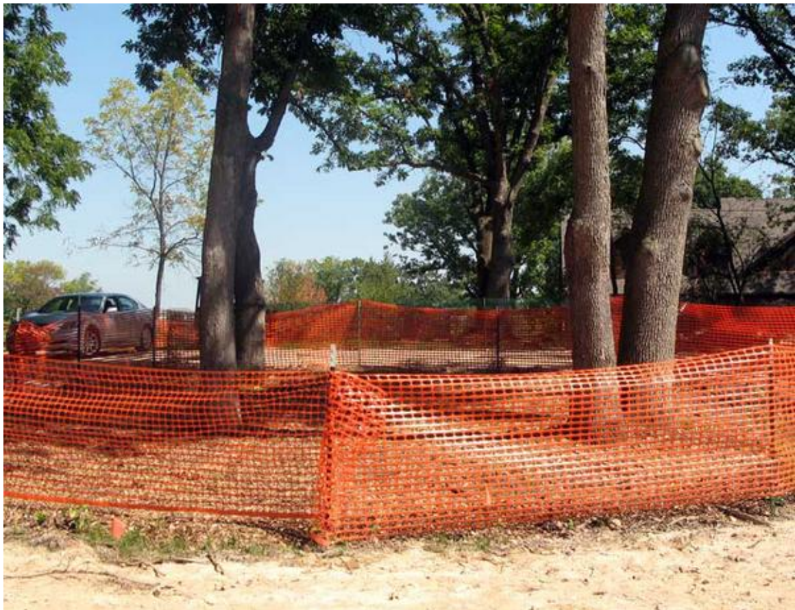
Εικόνα 8-4: Παράδειγμα περίφραξης για προστασία των κορμών των δέντρων
