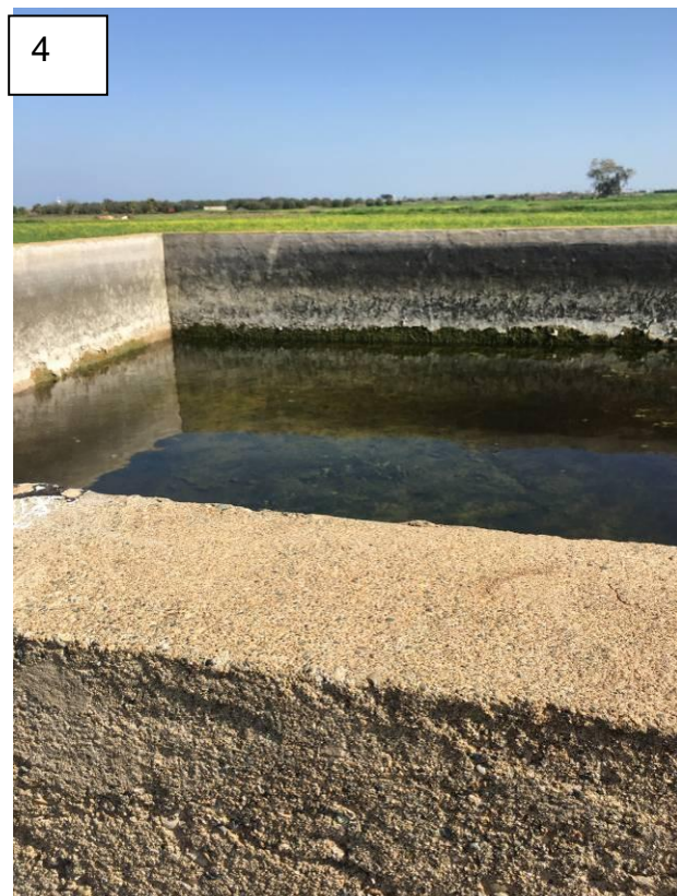
Η Φωτογραφία 4 απεικονίζει την δεξαμενή νερού εντός του τεμαχίου
