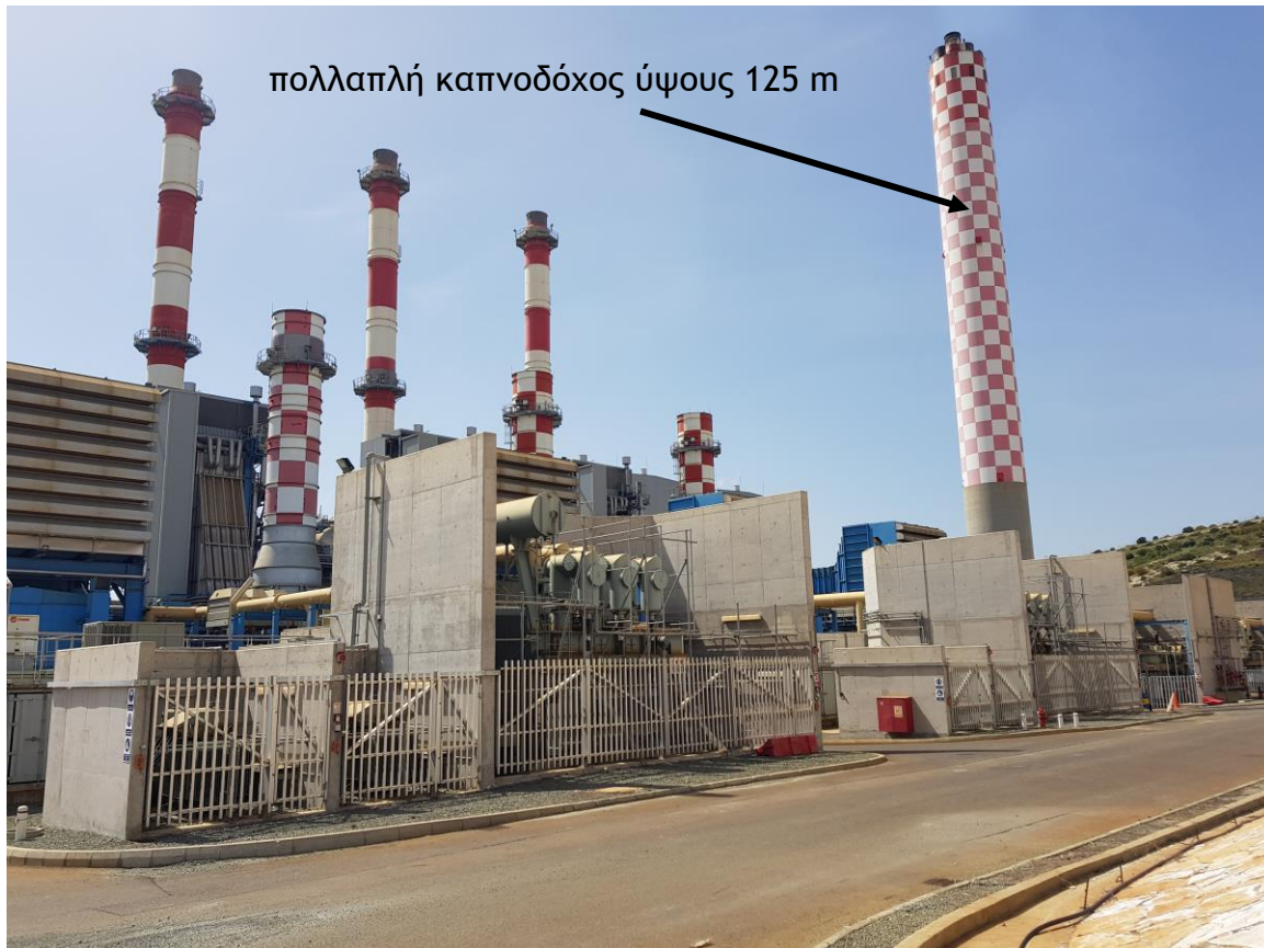
Εικόνα 5.4: Σύστημα πολλαπλής καπνοδόχου των συμβατικών μονάδων
