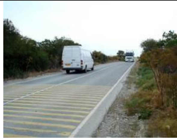
Εικόνα 3.71: Αποψη του δρόμου Β1
