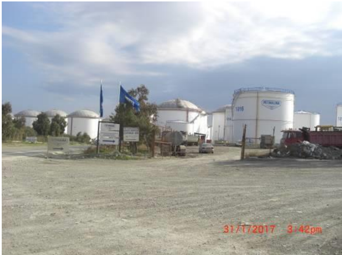
Εικόνα 3.11: Εγκαταστάσεις της PETROLINA (Holdings) Public Ltd. (Πηγή: AEOLIKI Ltd., 2017)
