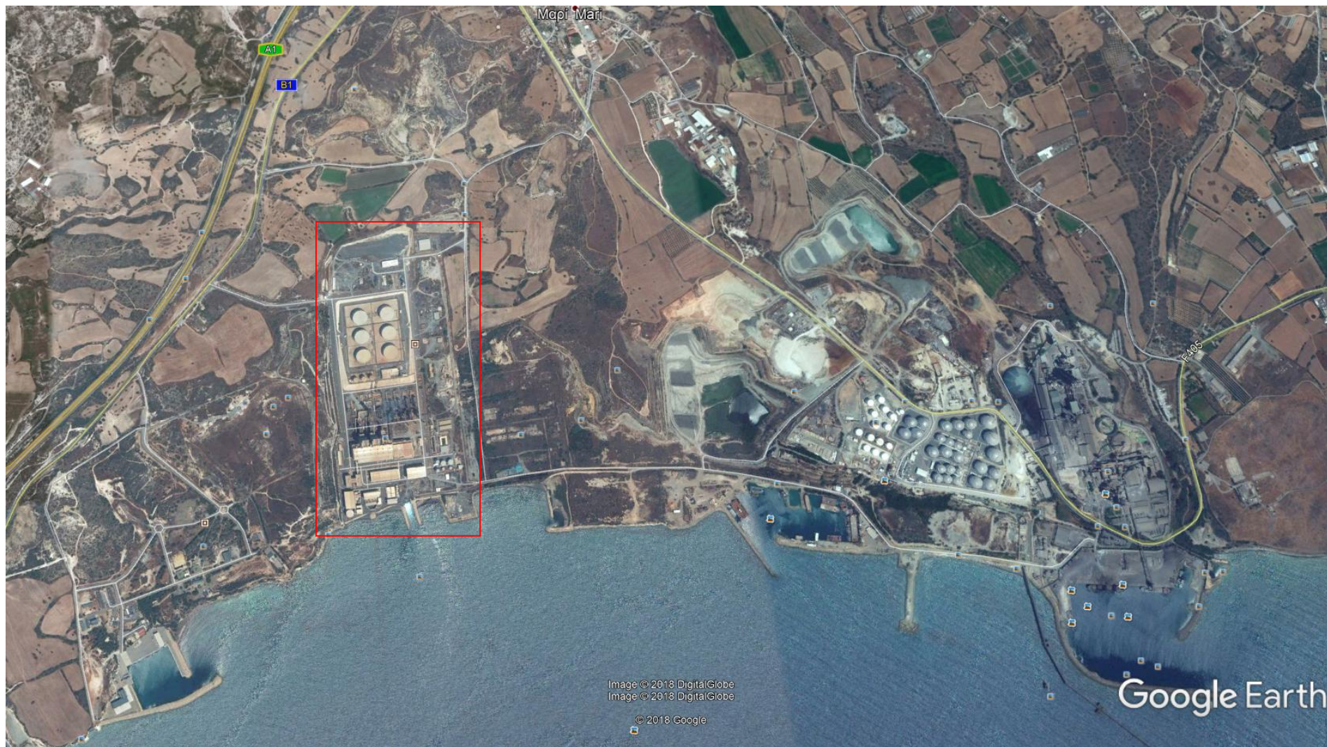
Εικόνα 5.1: Θέση Ηλεκτροπαραγωγού Σταθμού
