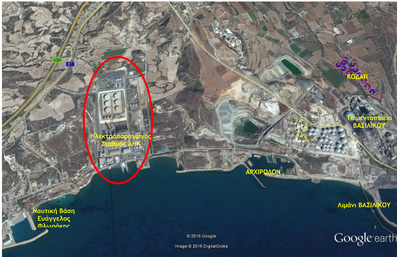
Εικόνα Γ.1 Ηλεκτροπαραγωγός Σταθμός Βασιλικού και σημαντικότερες γειτονικές εγκαταστάσεις (Πηγή: Vasilikos MasterPlan, 2015)
