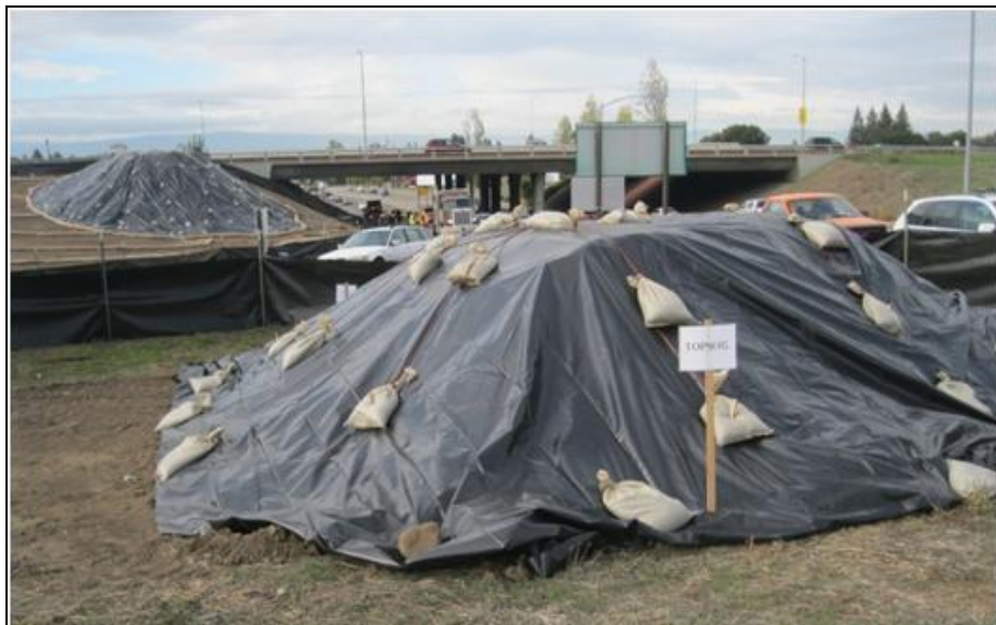
Εικόνα 8-2: Παράδειγμα διάταξης χώρου αποθήκευσης μπαζών/άμμου
