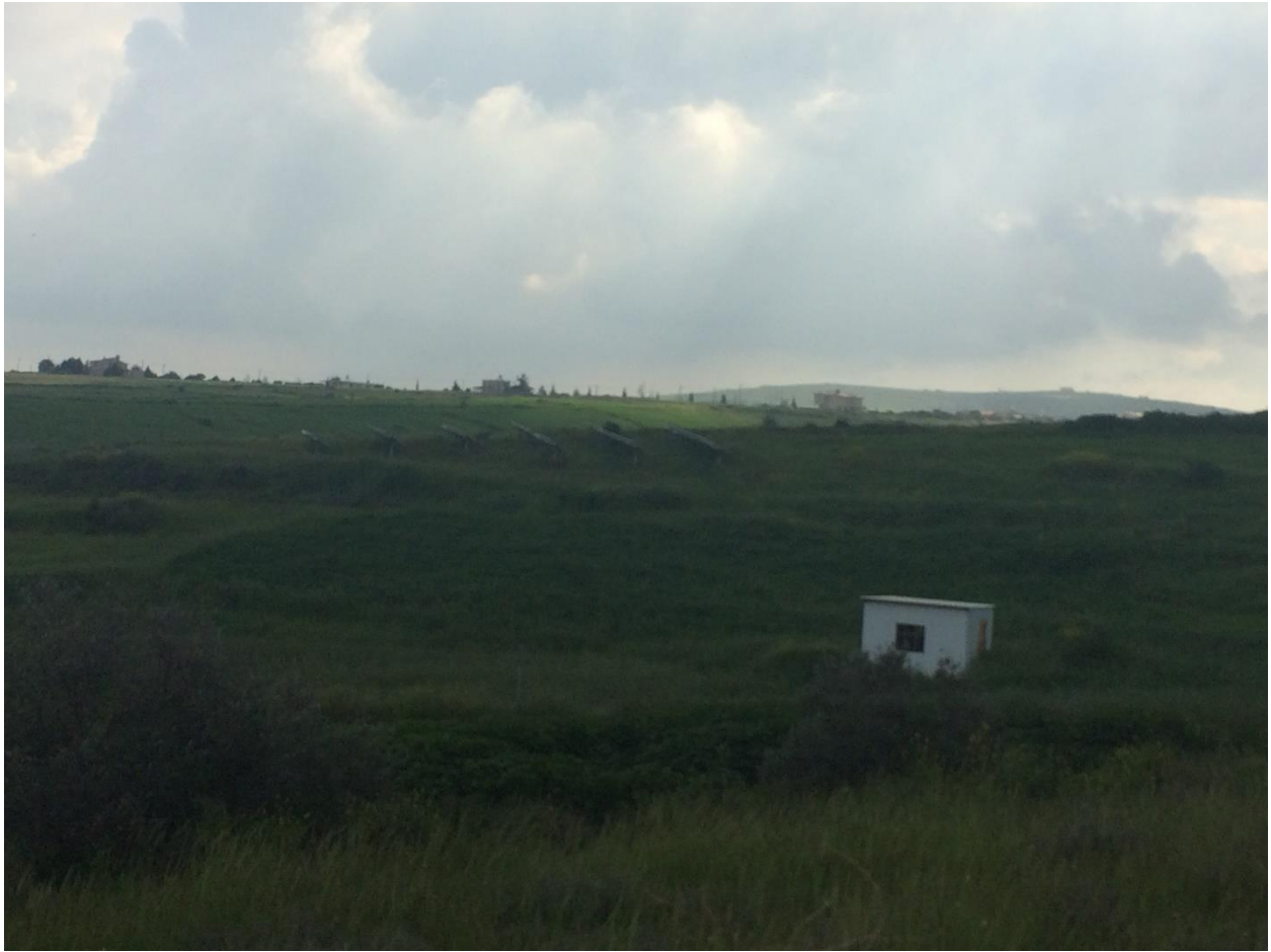
Φωτογραφία 2.2.4: Εγκατεστημένο ΦΒ πάρκο σε απόσταση 500 μέτρων από το ΠΕ
