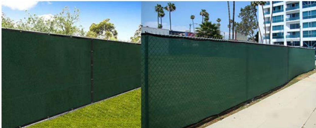
Εικόνα 7-5: Παράδειγμα περίφραξης εργοταξίου
