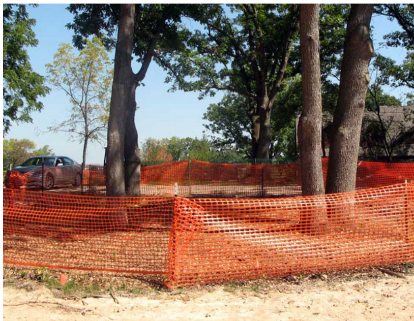
Εικόνα 7-6: Παράδειγμα περίφραξης για προστασία των δέντρων
