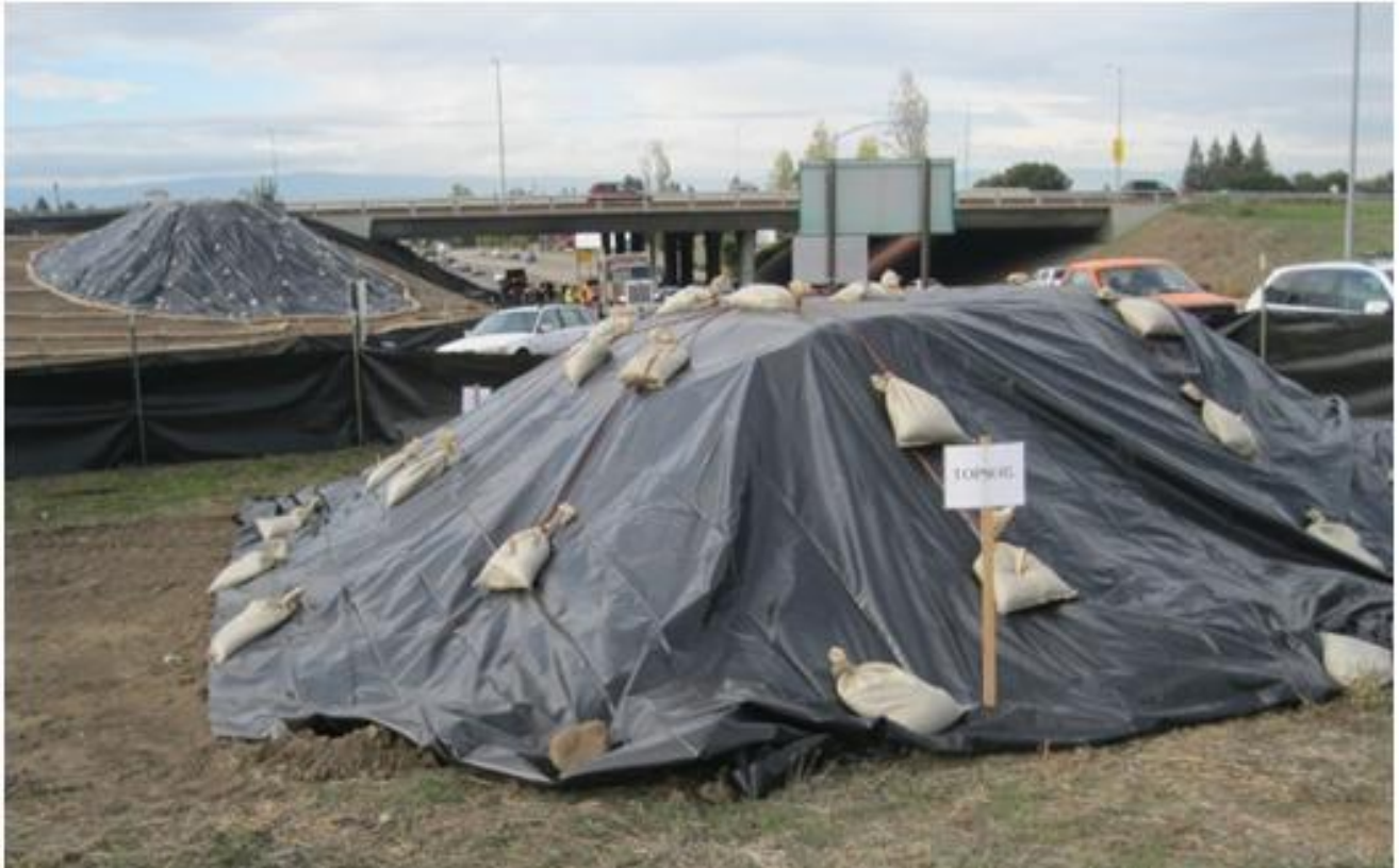
Εικόνα 7-1: Παράδειγμα διάταξης χώρου αποθήκευσης μπαζών/άμμου
