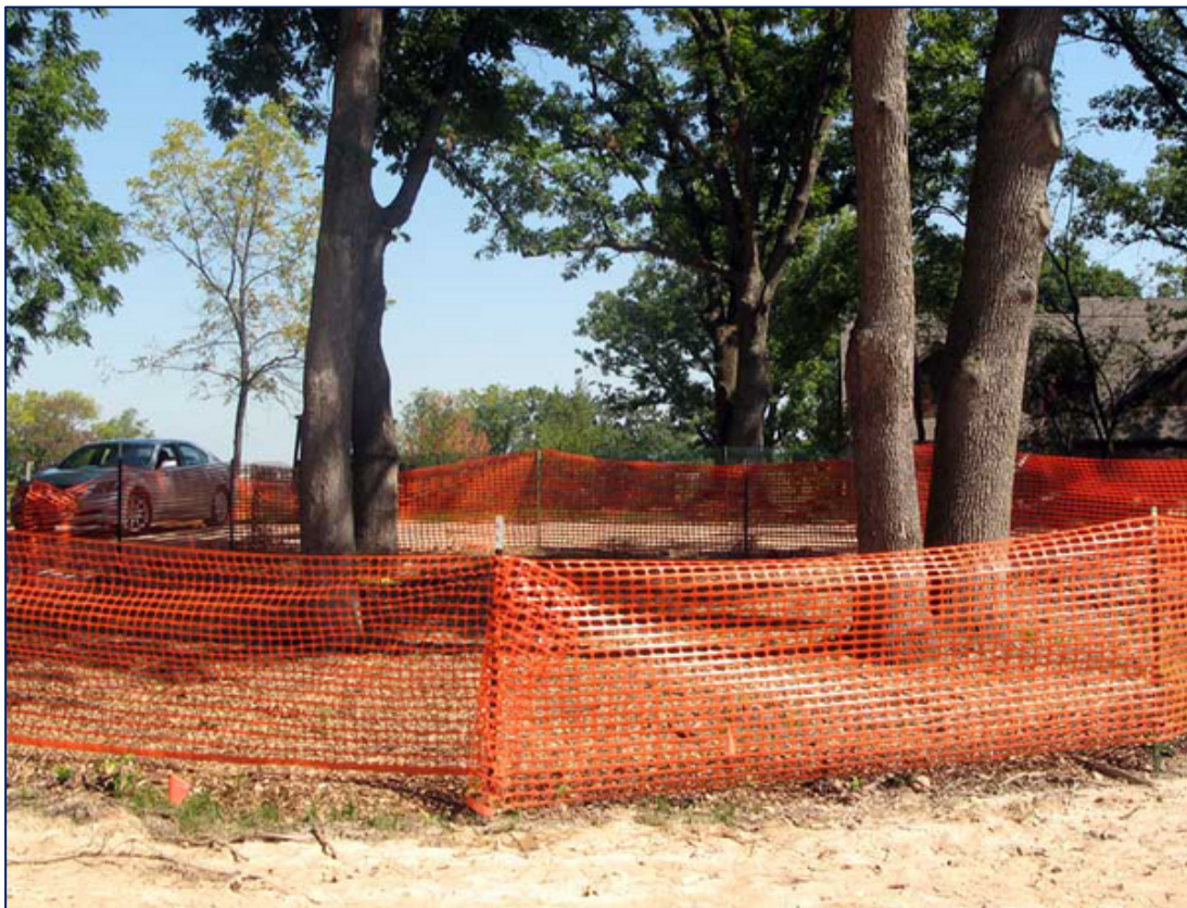
Εικόνα 7-6: Παράδειγμα περίφραξης για προστασία των δέντρων
