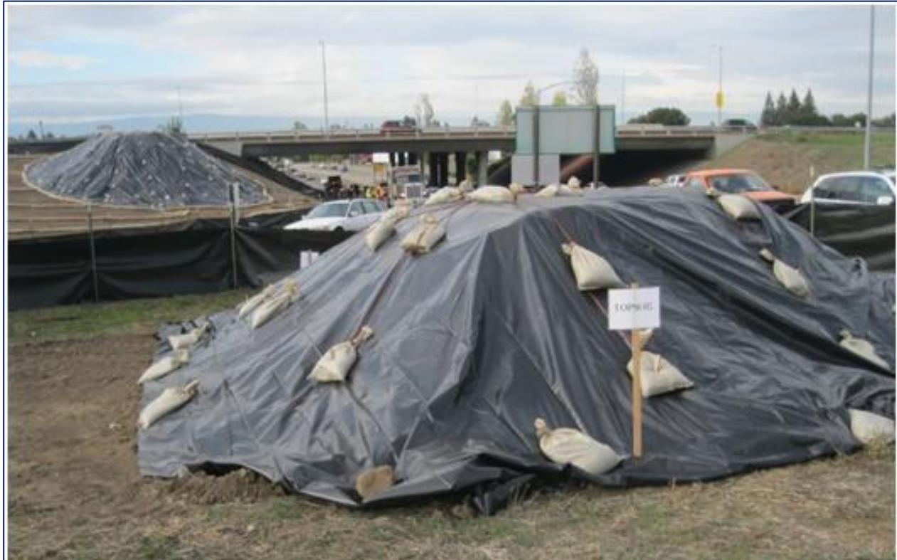
Εικόνα 7-1: Παράδειγμα διάταξης χώρου αποθήκευσης μπαζών/άμμου
