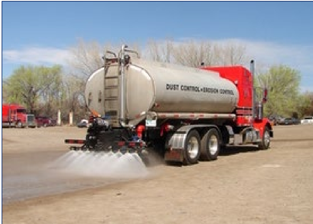
Εικόνα 7-2: Κατάβρεξη χωμάτινων οδών και περιοχή εργασίας
