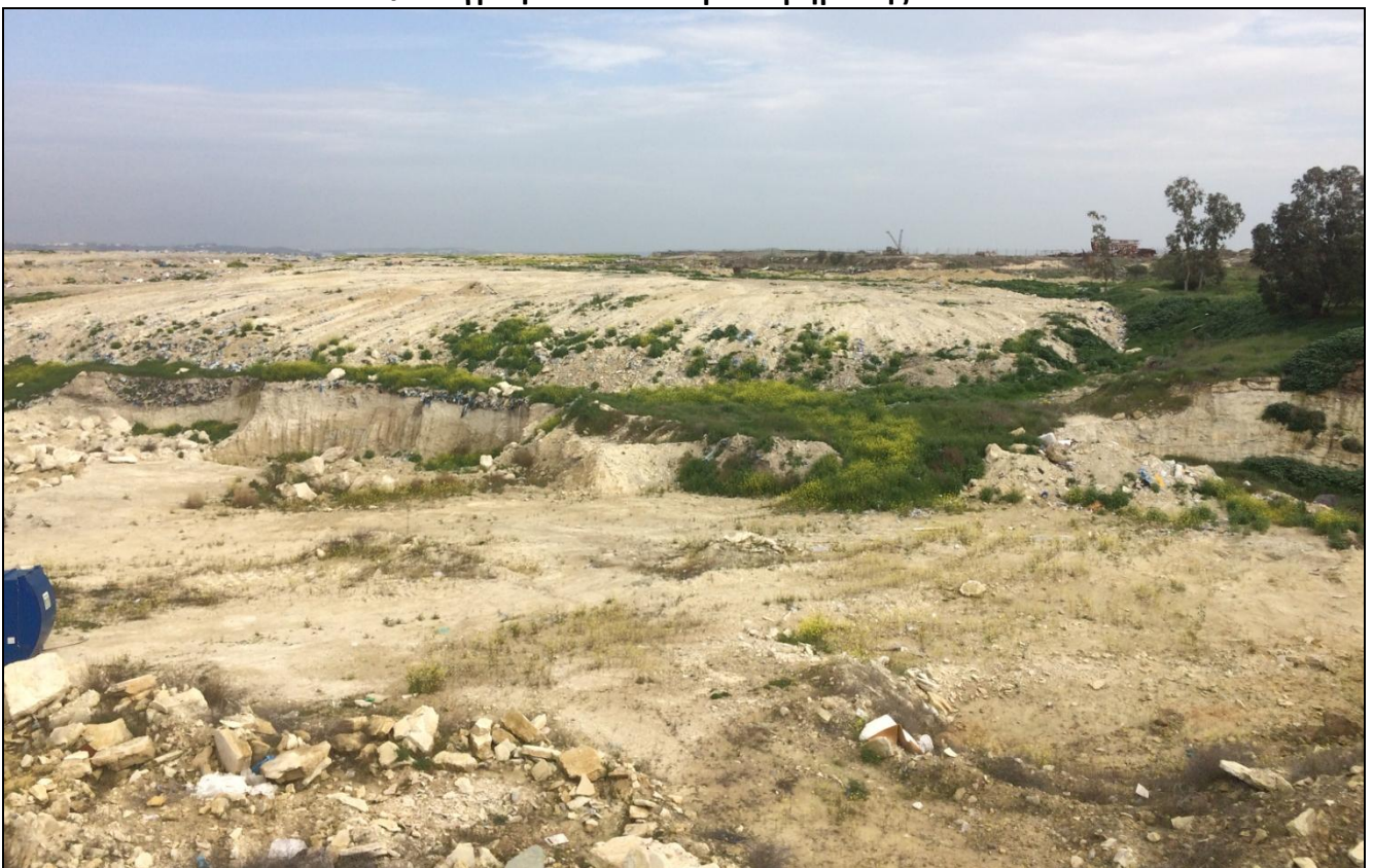
Φωτογραφία 16-20: Βόρειο τμήμα της ΑΠΜ
