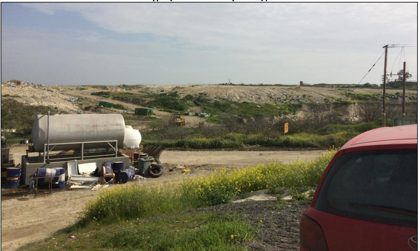
Φωτογραφία 16-22: Εργοταξιακός χώρος της ΑΠΜ
