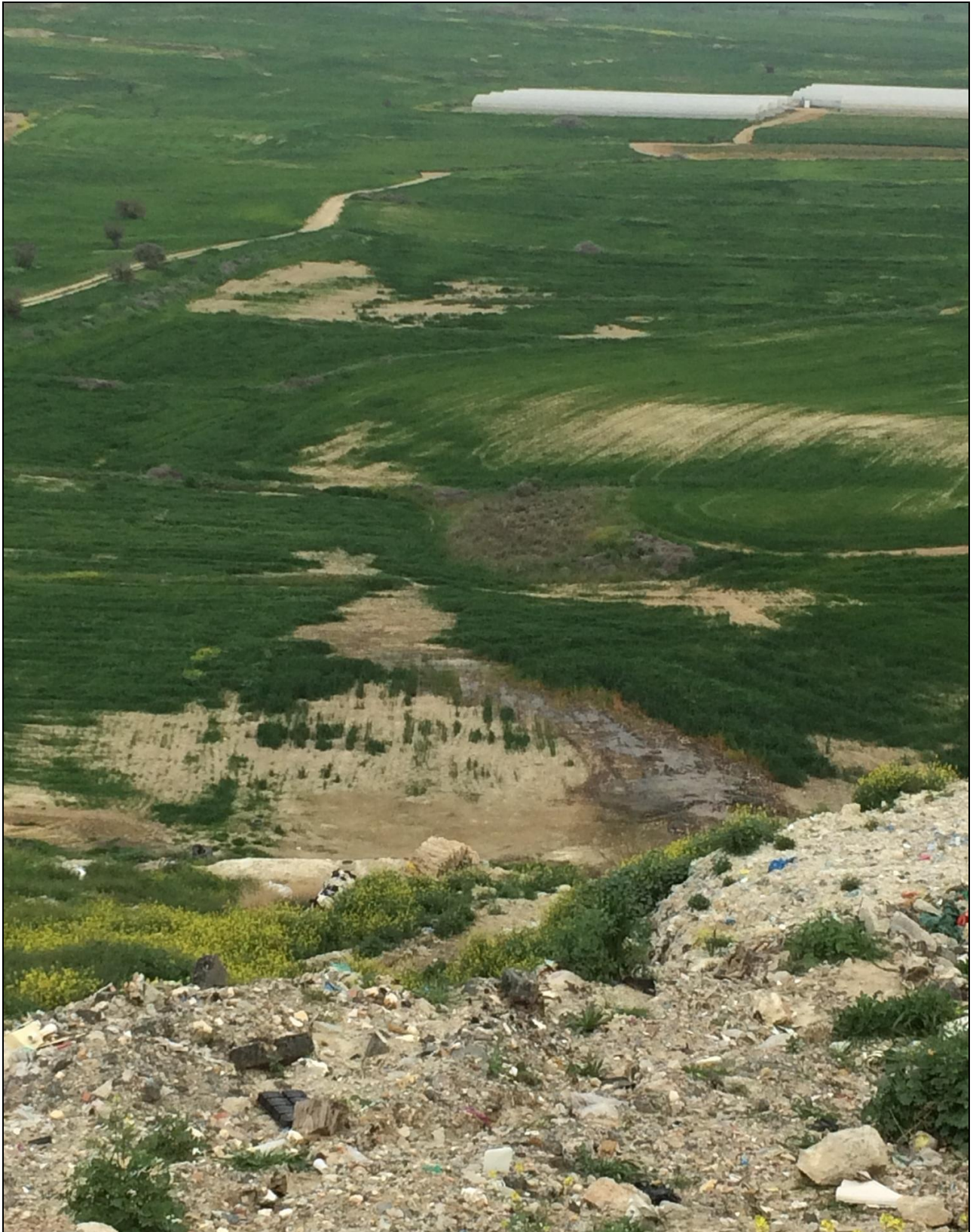
Φωτογραφία 16-9: Απορροή στραγγισμάτων από το απορριμματικό ανάγλυφο σε παρακείμενα τεμάχια. Βόρειο τμήμα του απορριμματικού ανάγλυφου
