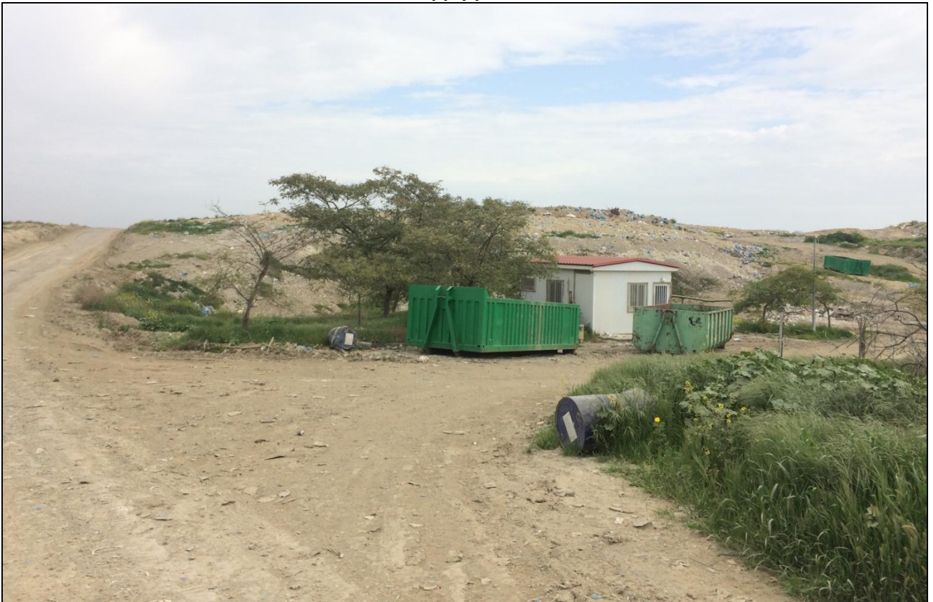
Φωτογραφία 16-3: Εργοταξιακός χώρος του ΧΑΔΑ Κοτσιάτη
