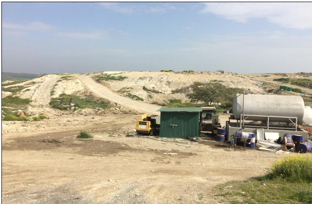
Φωτογραφία 16-23: Εργοταξιακός χώρος της ΑΠΜ
