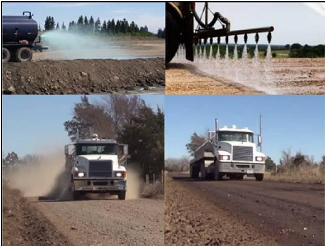
Εικόνα 9-4: Μέθοδος διαβροχής χωμάτινων οδών για τον περιορισμό εκπομπής σκόνης
