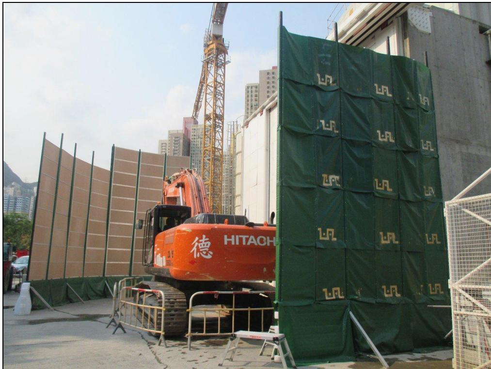
Εικόνα 9-2: Χρήση ακουστικών ηχοπετασμάτων γύρω από την περιοχή όπου πραγματοποιούνται εργασίες από εκσκαφέα και προκαλούνται υψηλά επίπεδα θορύβου
