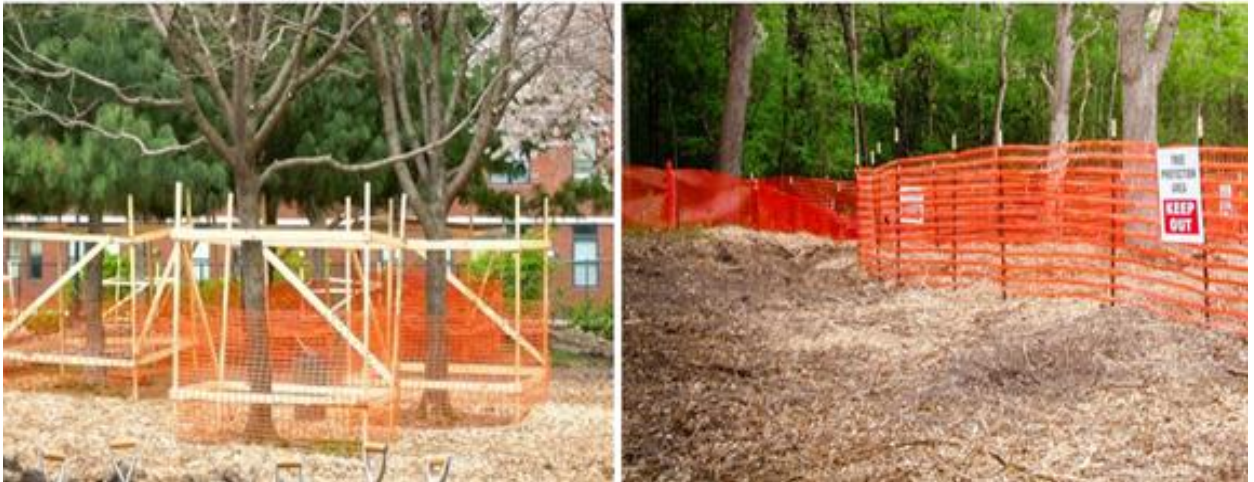
Εικόνα 9-7: Παραδείγματα προστασίας κορμών δέντρων
