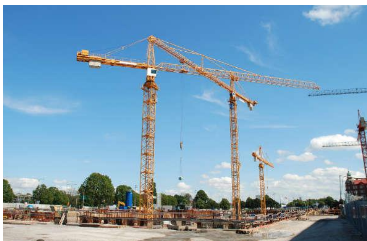
Εικόνα 6-8: Γερανός σταθερής βάσης (tower crane)
