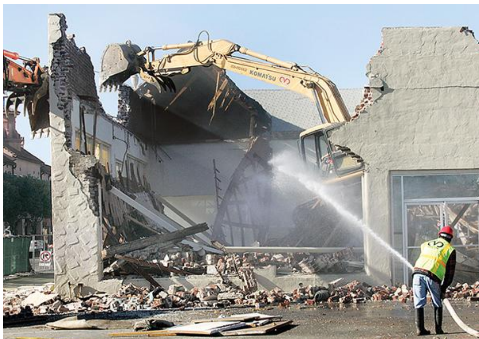
Εικόνα 9-3: Διαβροχή του χώρου κατεδάφισης
