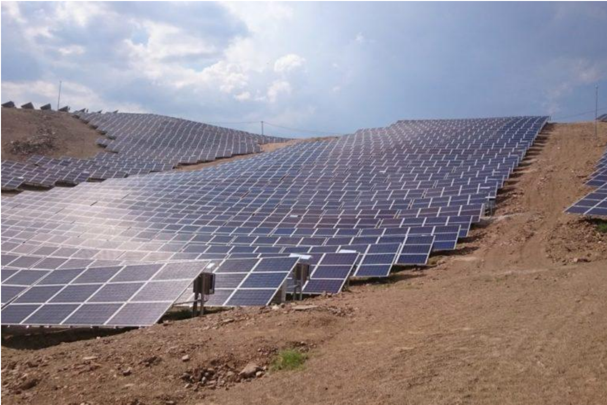
Εικόνα 6-13: Παράδειγμα Φωτοβολταϊκού πάρκου σε τεμάχιο με κλίση
