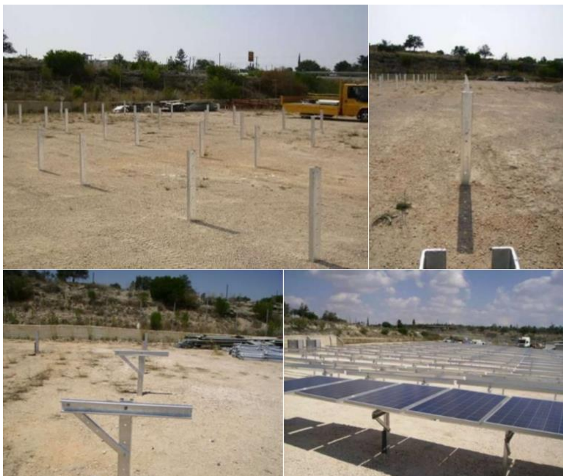
Εικόνα 5-1. Παράδειγμα θεμελίωσης και εγκατάστασης ΦΒ πλαισίων με την μέθοδο της πασσαλόμπτυξης.
