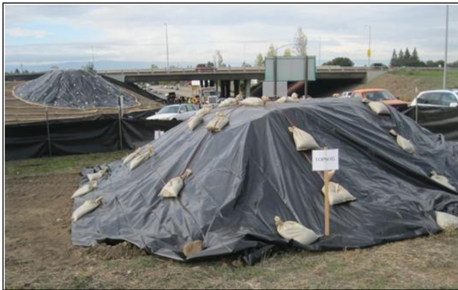
Εικόνα 8-2: Παράδειγμα διάταξης χώρου αποθήκευσης μπαζών/άμμου
