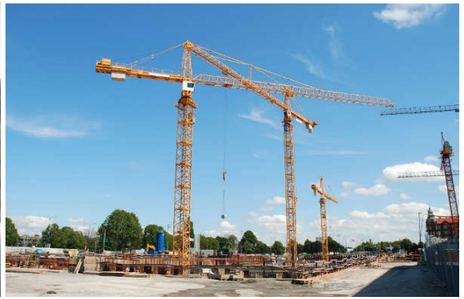
Εικόνα 6-6: Γερανός (αριστερά) και Γερανός σταθερής βάσης (δεξιά)
