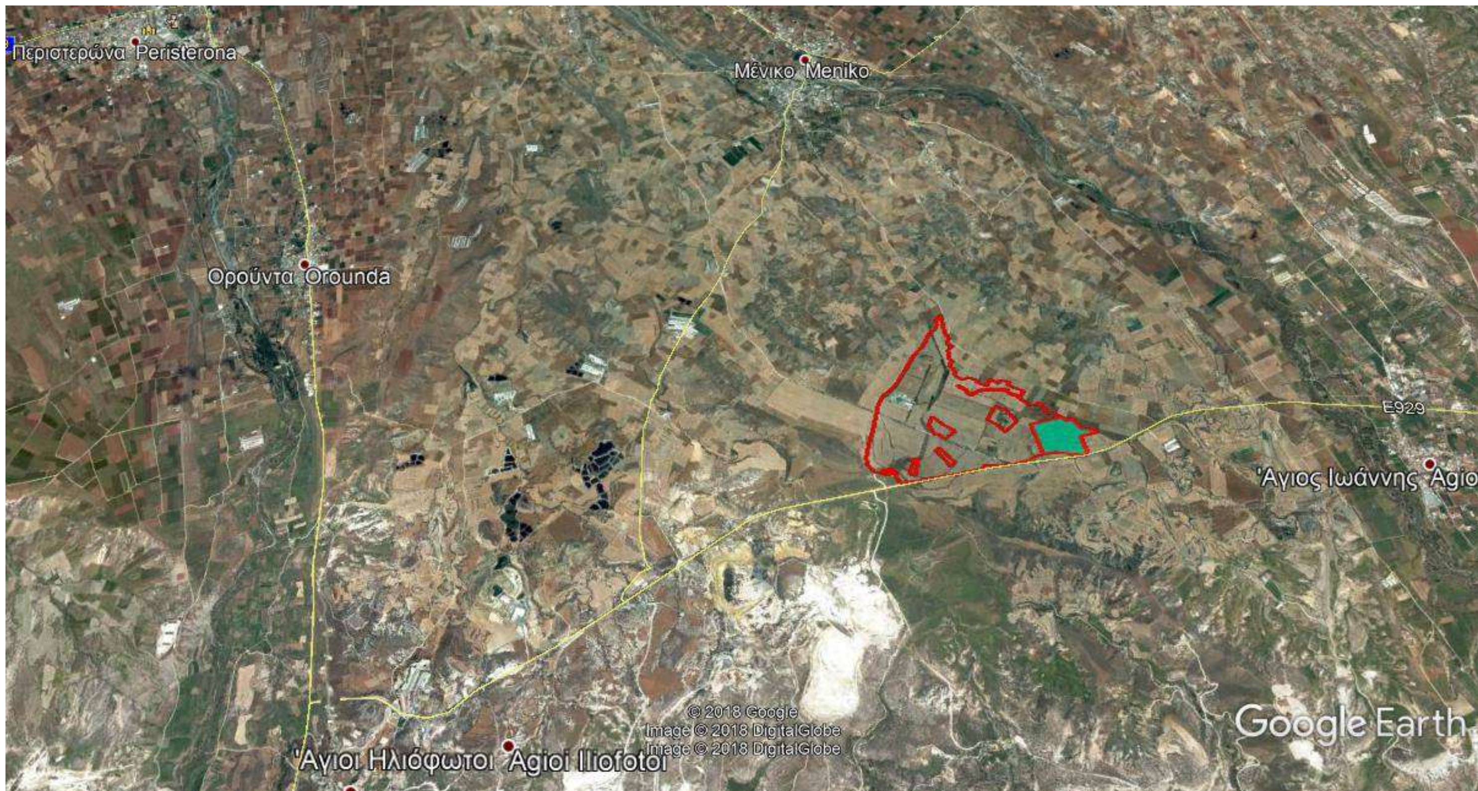
Εικόνα 4.2: Τοποθεσία Εγκατάστασης Φωτοβολταϊκού Πάρκου Ισχύος 5 MW στην θέση Αχεράς Β της κοινότητας Αγίου Ιωάννη, Επαρχίας Λευκωσίας
