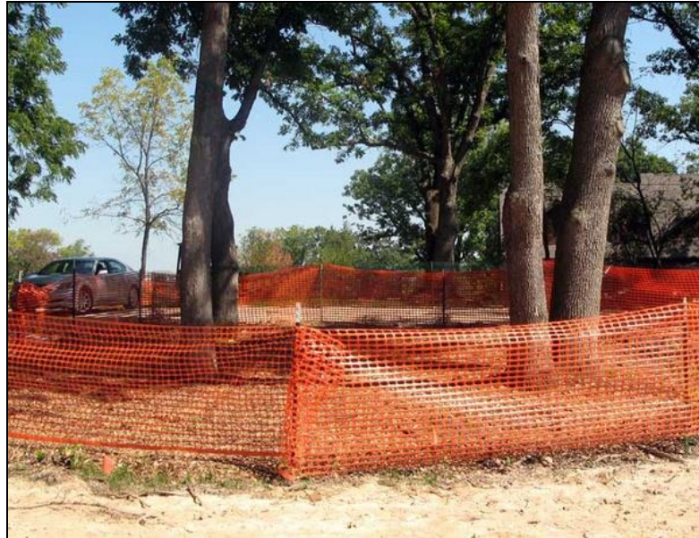
Εικόνα 9-4: Παράδειγμα περίφραξης για προστασία των δέντρων
