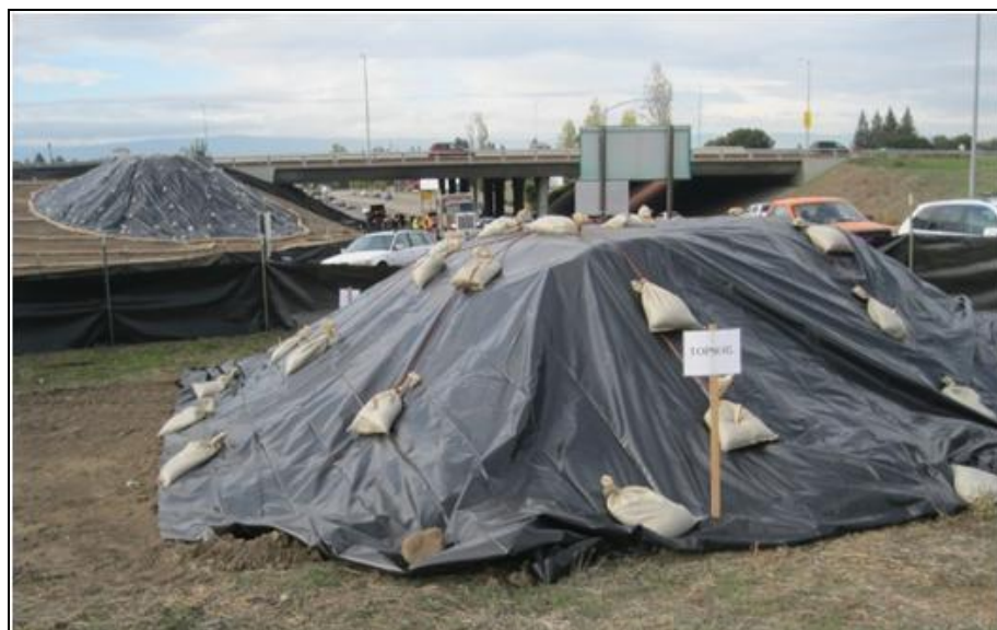
Εικόνα 9-2: Παράδειγμα διάταξης χώρου αποθήκευσης μπαζών/άμμου
