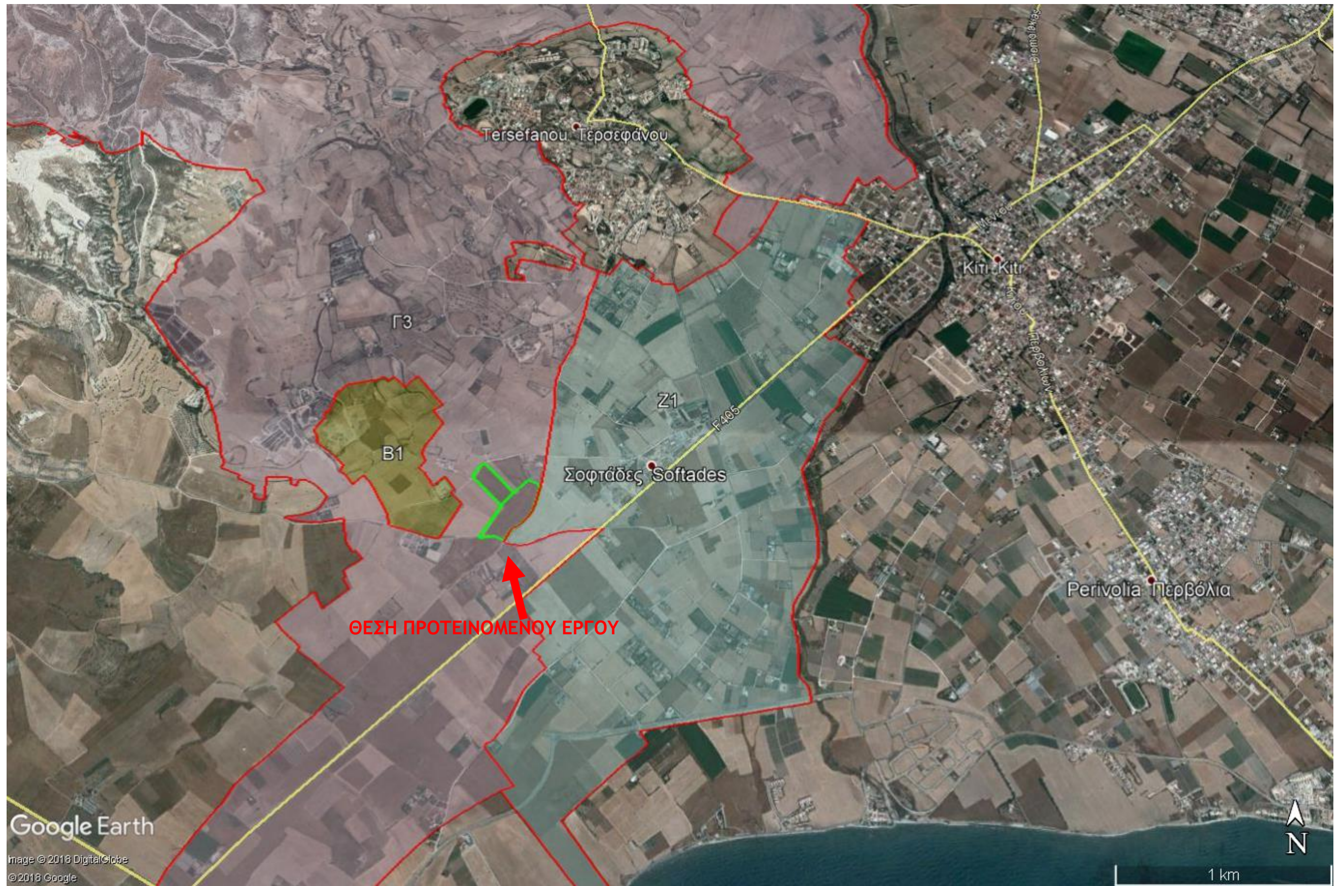
Σχήμα 3.2: Τοποθεσία Εγκατάστασης Φωτοβολταϊκού Πάρκου Ισχύος 6 MW στην κοινότητα Τερσεφάνου, Επαρχίας Λάρνακας (Δορυφορική Φωτογραφία)
