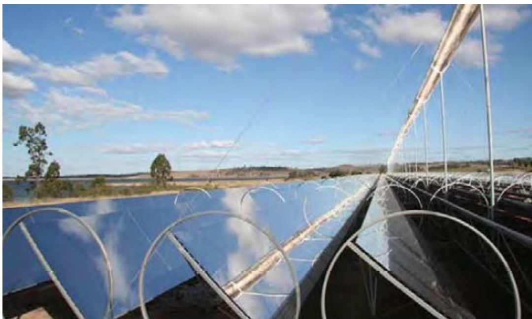
Σχήμα 1.2: Σύστημα Linear Fresnel Reflector
