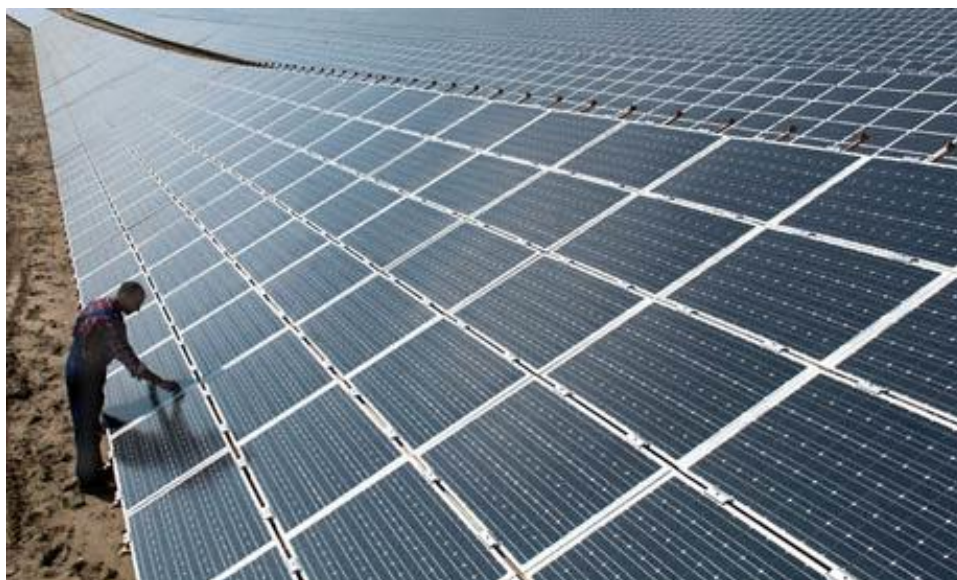
Σχήμα 7.1: Καθαρισμός Πλαισίων
