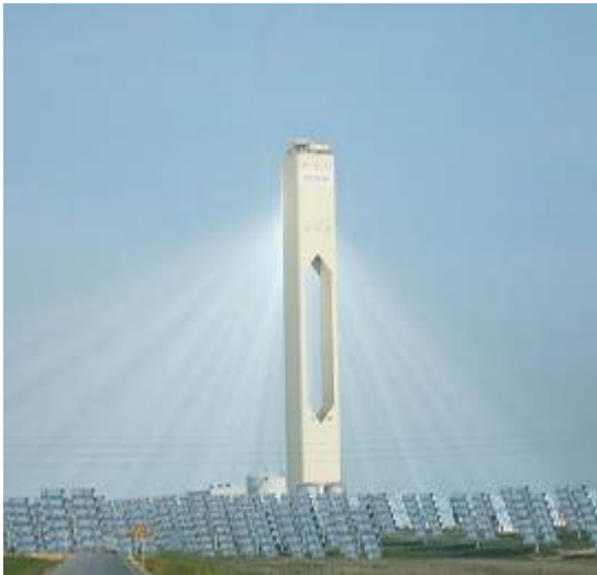
Σχήμα 1.1: Κεντρικός ηλιακός πύργος ισχύος
