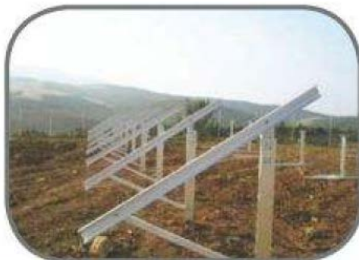
Εικόνα 6-8: Σχέδιο πασαλλόμησης Βάσης Φωτοβολταϊκών Πινάκων (πηγή: Metaloumin)
