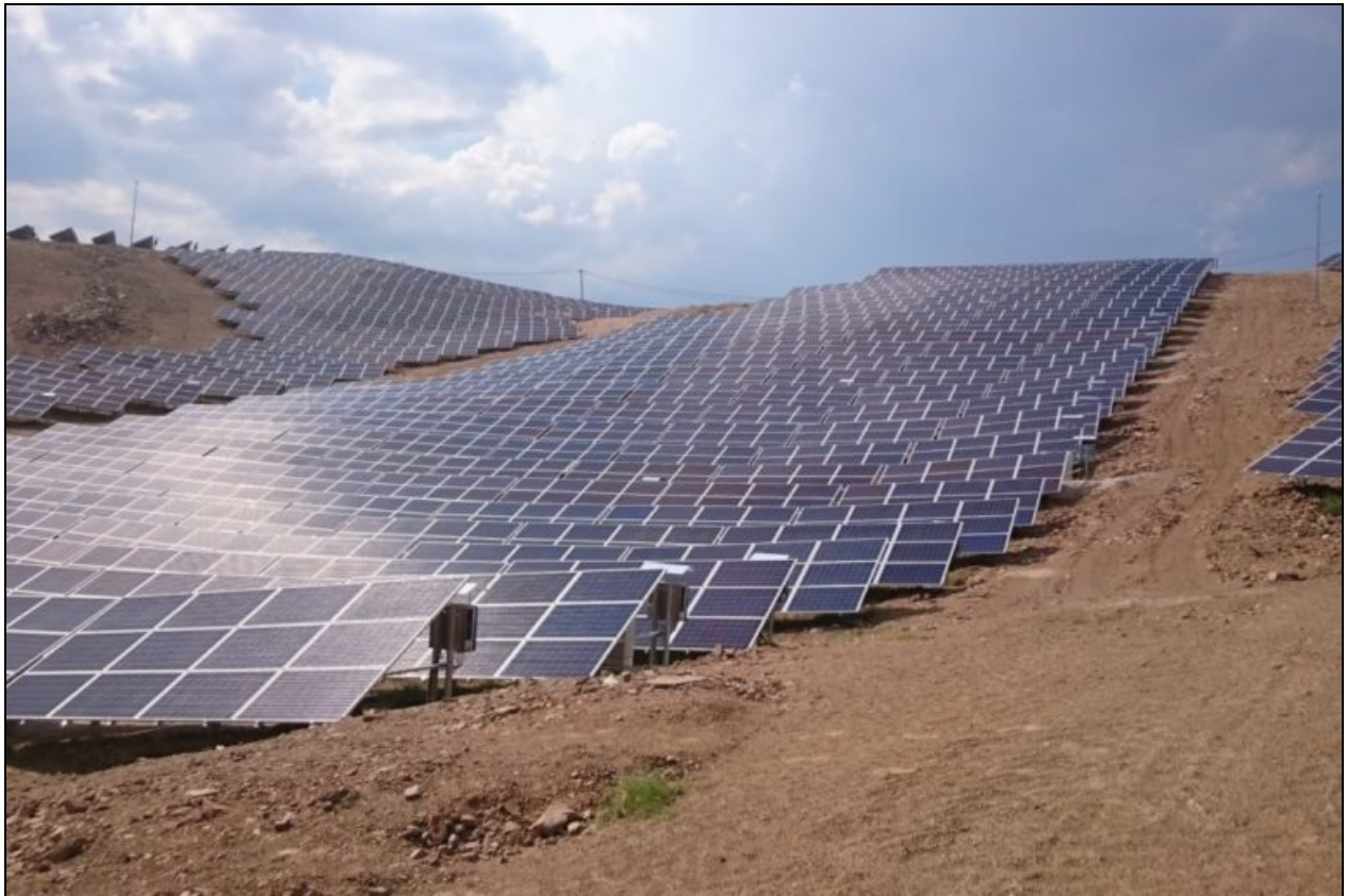
Εικόνα 6-9: Παράδειγμα Φωτοβολταϊκού πάρκου σε τεμάχιο με κλίση
