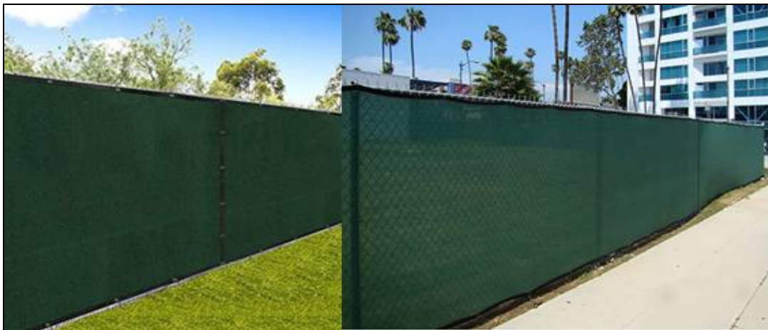
Εικόνα 9-3: Παράδειγμα περίφραξης εργοταξίου
