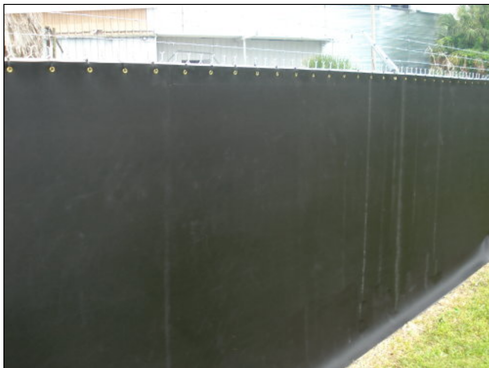
Εικόνα 9-3: Περίφραξη από συμπαγή υλικά
