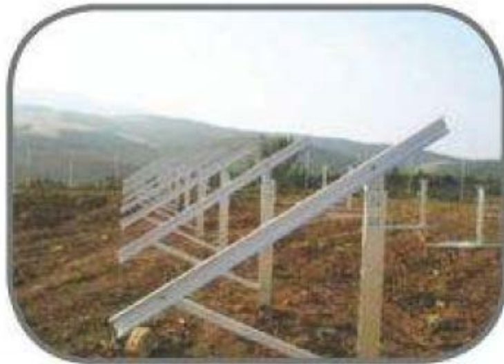
Εικόνα 6-8: Σχέδιο πασαλλόμπτυξης Βάσης Φωτοβολταϊκών Πινάκων (πηγή: Metaloumin)
