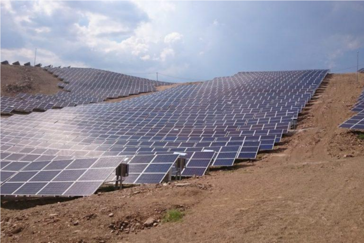
Εικόνα 6-13: Παράδειγμα Φωτοβολταϊκού πάρκου σε τεμάχιο με κλίση
