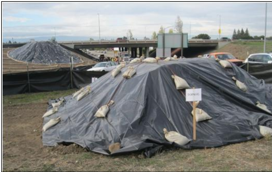
Εικόνα 9-2: Παράδειγμα διάταξης χώρου αποθήκευσης μπαζών/άμμου
