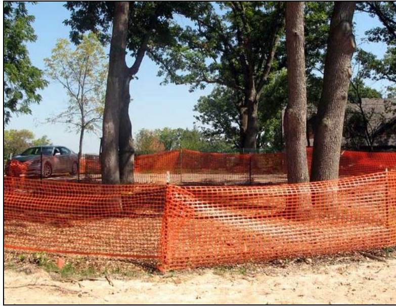
Εικόνα 9-4: Παράδειγμα περίφραξης για προστασία των δέντρων
