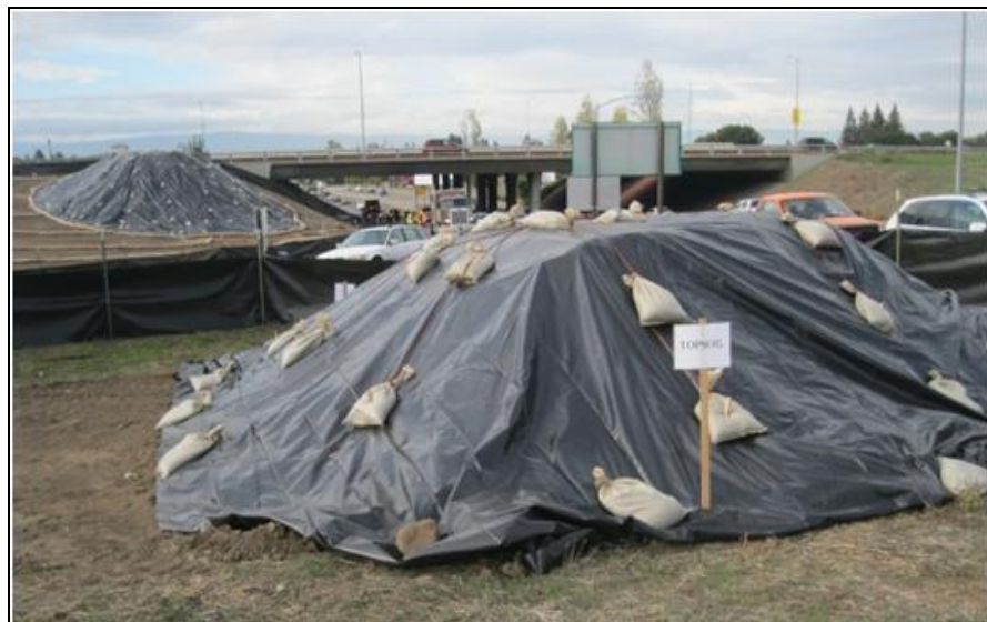
Εικόνα 9-2: Παράδειγμα διάταξης χώρου αποθήκευσης μπαζών/άμμου
