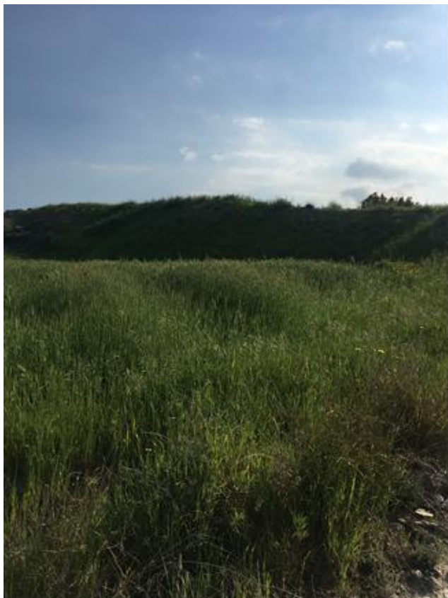
Φωτογραφία 4-3: Πρανές με απότομη κλίση στο βορειοανατολικό τμήμα του τεμαχίου 486.
