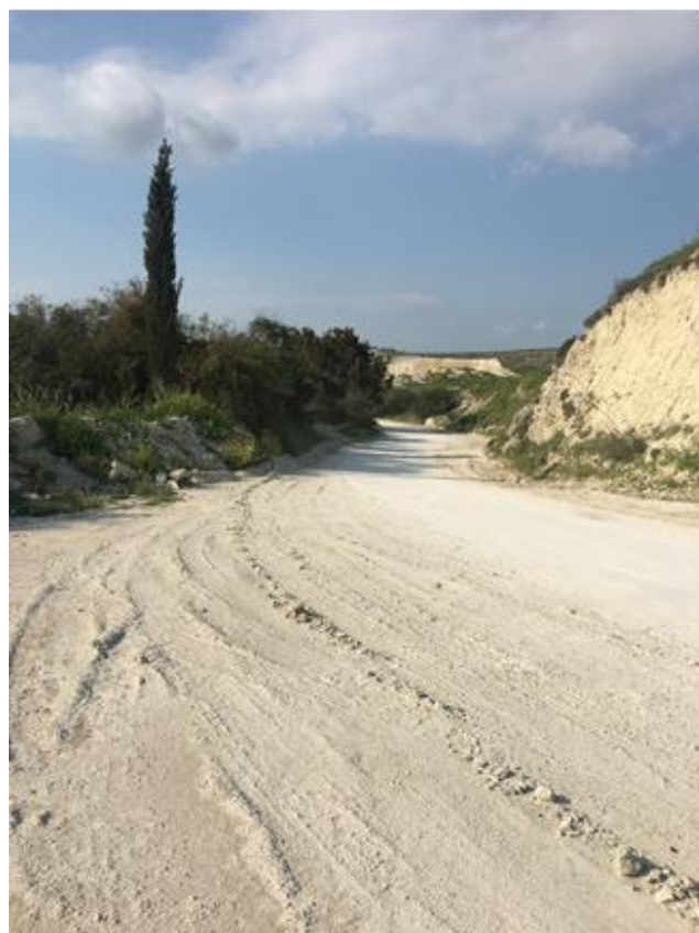
Φωτογραφία 4-1: Χωματόδρομος και πρανές με απότομη κλίση στο ανατολικό τμήμα του τεμαχίου 486
