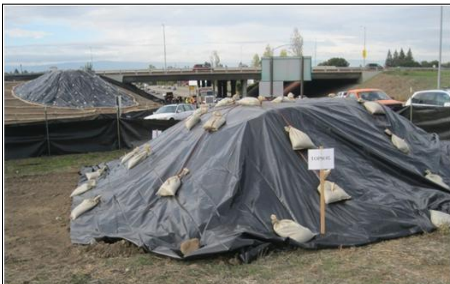
Εικόνα 9-2: Παράδειγμα διάταξης χώρου αποθήκευσης μπαζών/άμμου
