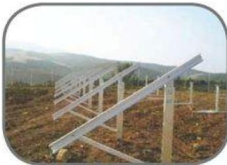
Εικόνα 6-8: Σχέδιο πασαλλόμπτυξης Βάσης Φωτοβολταϊκών Πινάκων (πηγή: Metaloumin)
