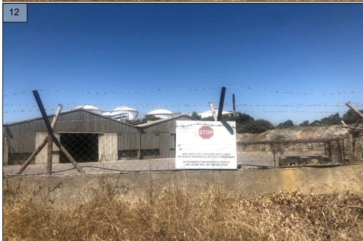
Φωτογραφίες 11-12: Εγκαταλελειμμένη βιομηχανική εγκατάσταση που εφάπτεται με το βόρειο σύνορο του χώρου κατασκευής του προτεινόμενου έργου, εντός του τεμαχίου 571
