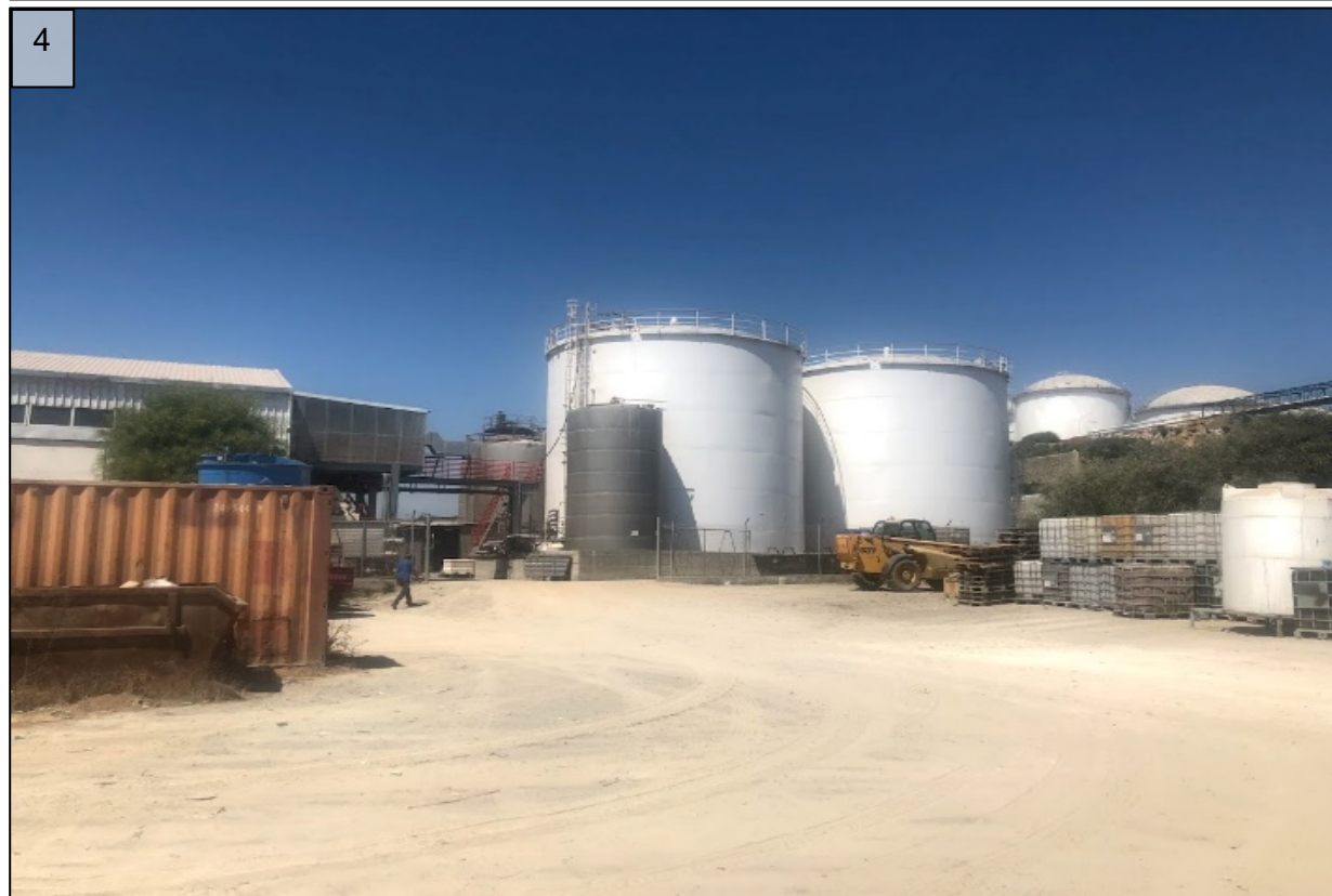
Φωτογραφίες 3-4: Οι βιομηχανικές εγκαταστάσεις που εφάπτονται του δυτικού συνόρου του χώρου κατασκευής του προτεινόμενου έργου, εντός του τεμαχίου 571
