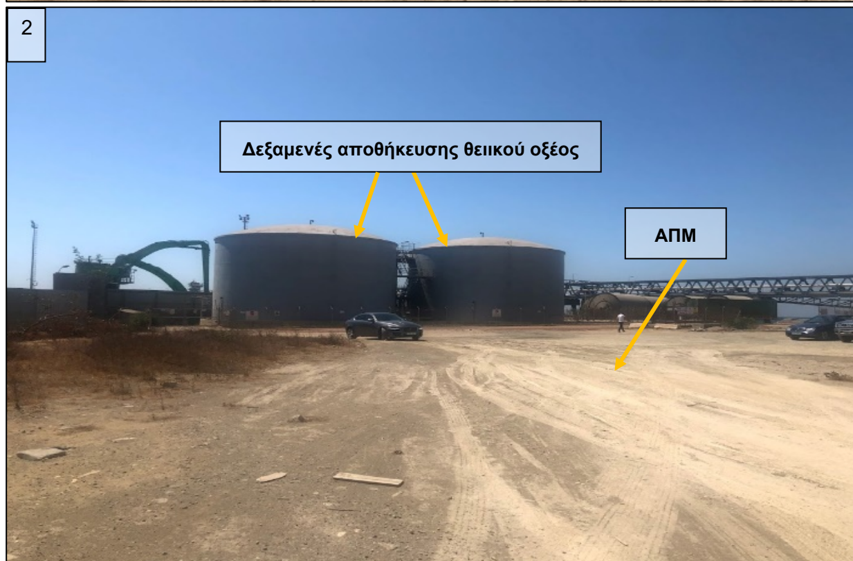
Φωτογραφίες 1-2: Το νότιο τμήμα του χώρου κατασκευής του προτεινόμενου έργου εντός του τεμαχίου 571
