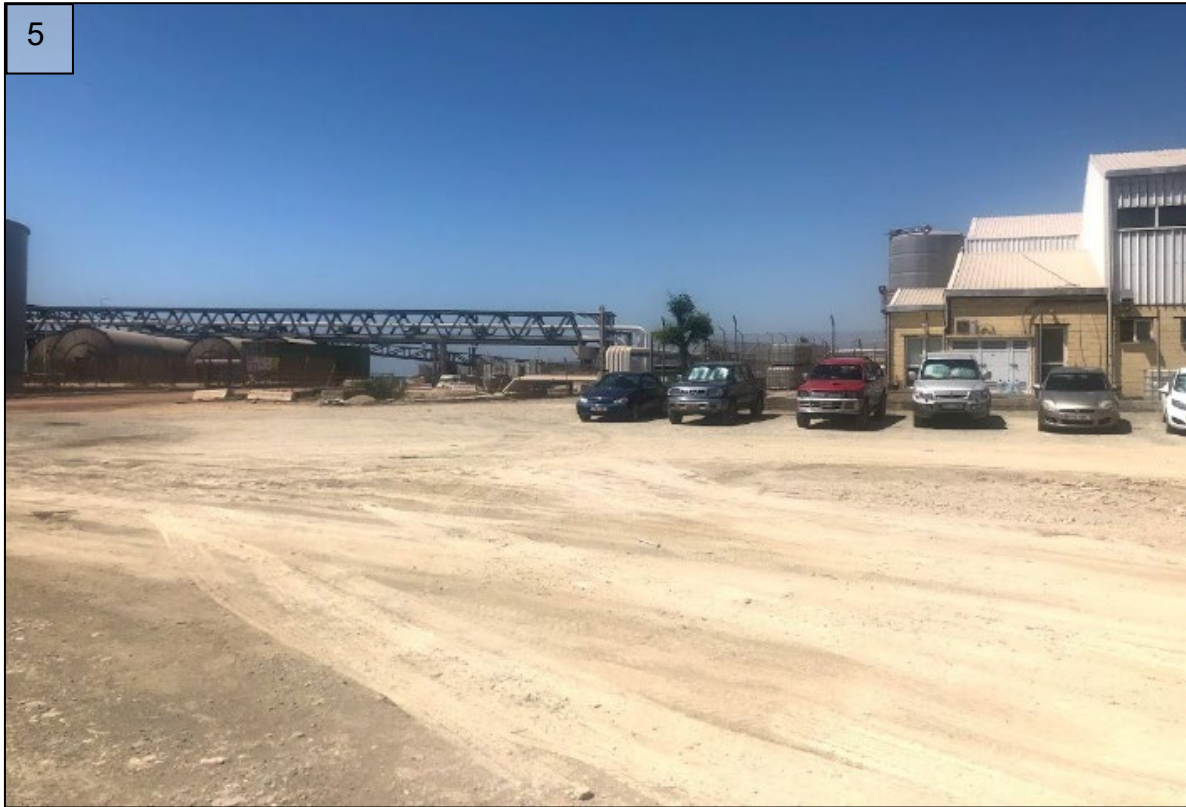
Φωτογραφία 5: Το δυτικό τμήμα του χώρου κατασκευής του προτεινόμενου έργου, εντός του τεμαχίου 571
