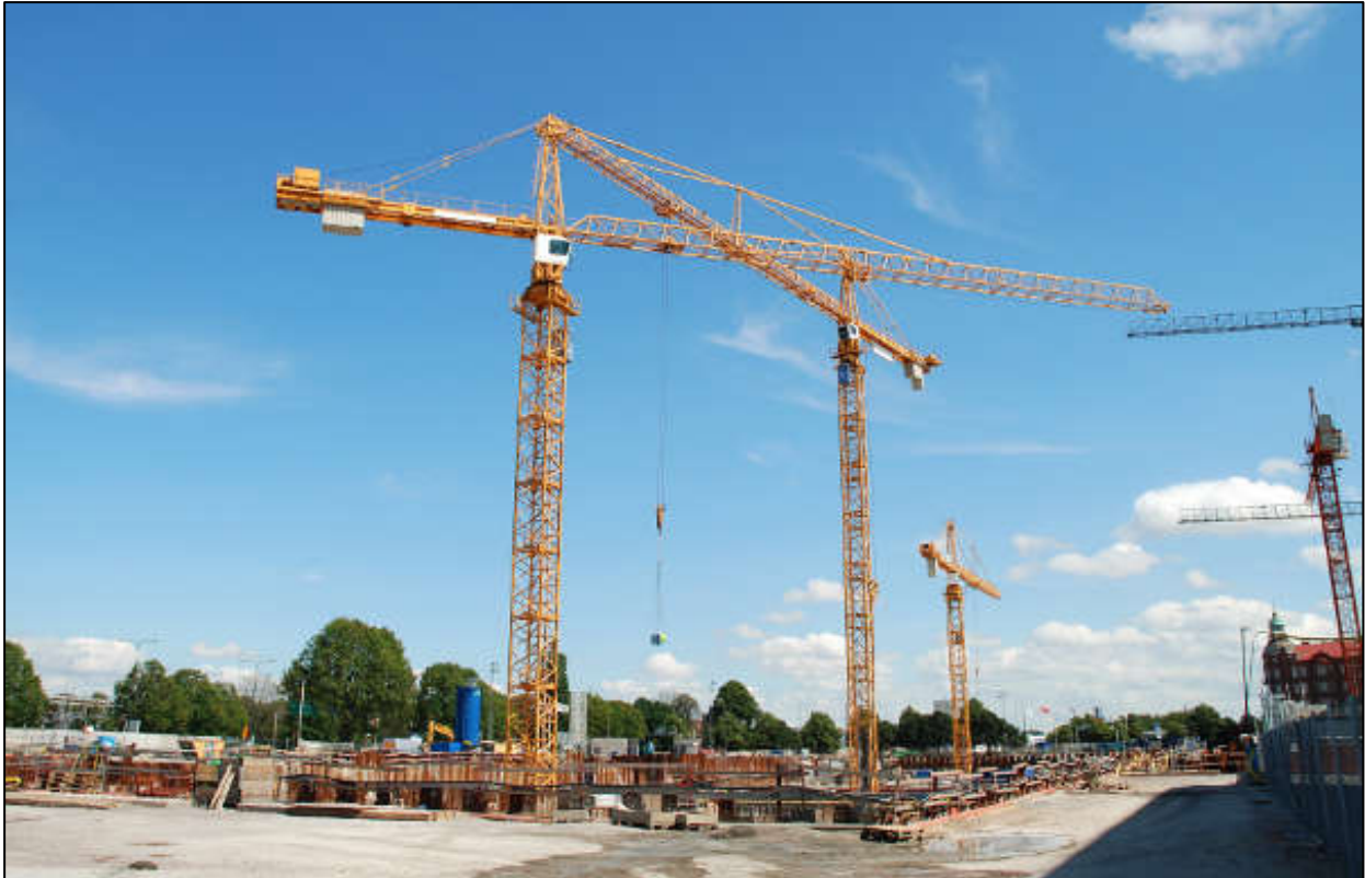
Εικόνα 6-8: Γερανός σταθερής βάσης
