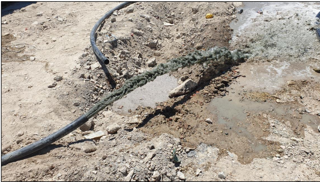
Φωτογραφία 5: Νερό άντλησης με υψηλή συγκέντρωση αιρούμενων σωματιδίων
