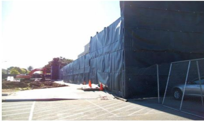
Εικόνα 7-1 : Χρήση Ηχοπετασμάτων στην περιοχή όπου πραγματοποιούνται εργασίες
