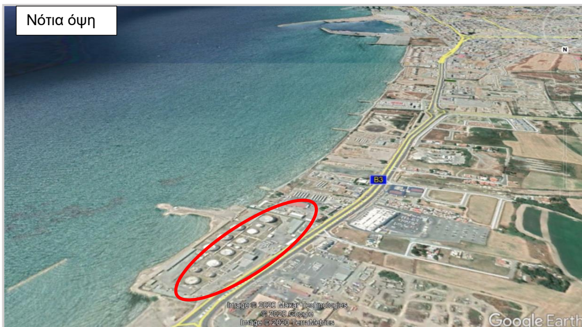
Εικόνα 4.2: Νότια όψη ΕΠΜ
