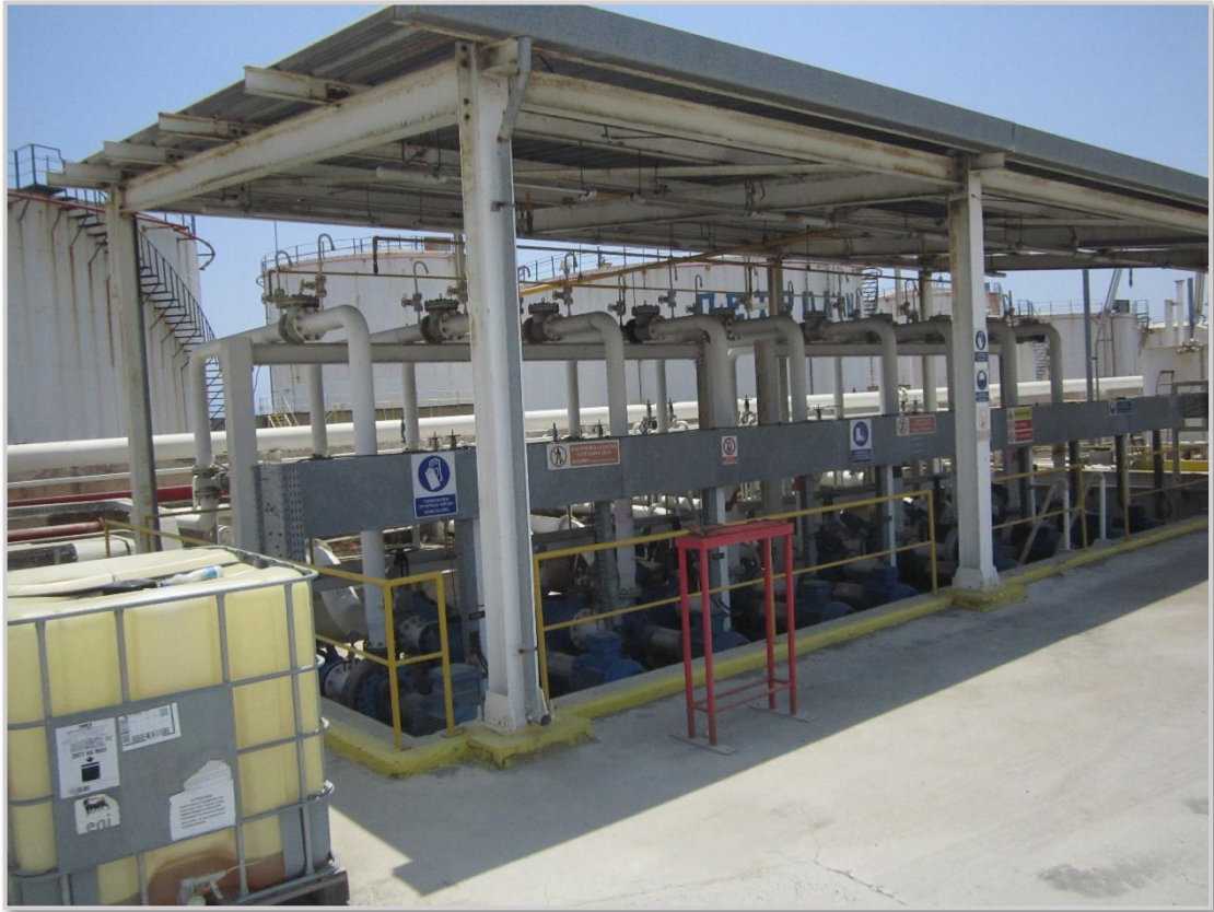
Εικόνα 3.15: Αντλίες φόρτωσης
