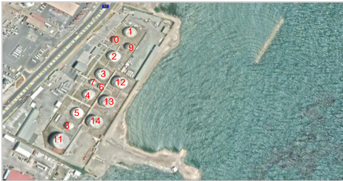
Εικόνα 3.4. Αεροφωτογραφία του υπό μελέτη τεμαχίου - αρίθμηση δεξαμενών (Πηγή: Google Earth)
