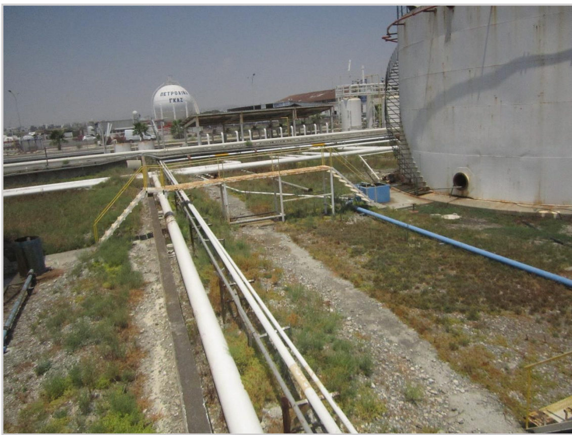
Εικόνα 4.8. Εποχιακή άγρια βλάστηση εντός του υπό μελέτη τεμαχίου
