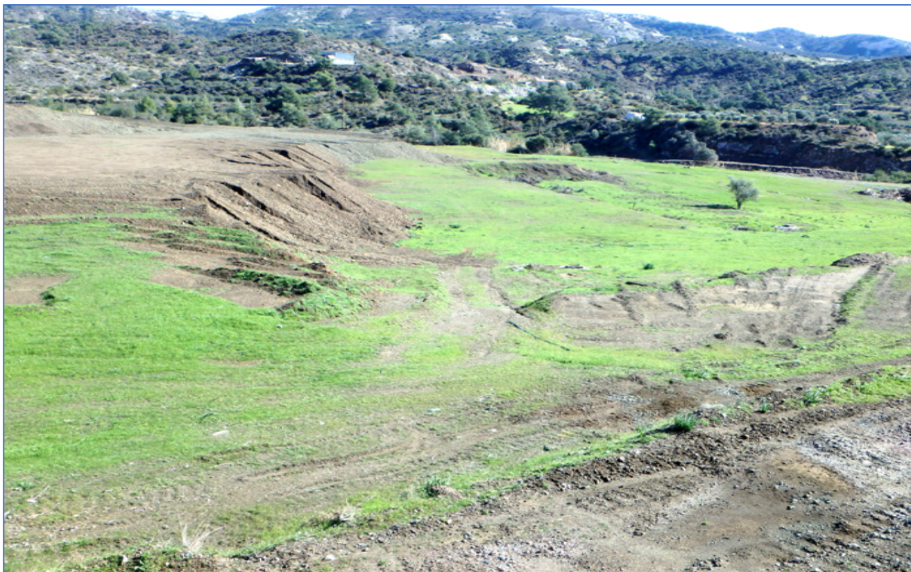
Φωτογραφία 7-1: Από Δυτικά προς Ανατολικά – Νότια πλευρά του τεμαχίου προς υδατόρεμα
