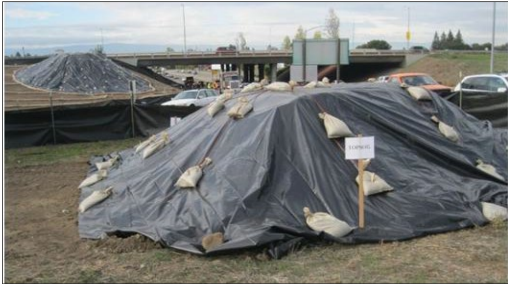
Εικόνα 9-2: Παράδειγμα διάταξης χώρου αποθήκευσης μπαζών/άμμου
