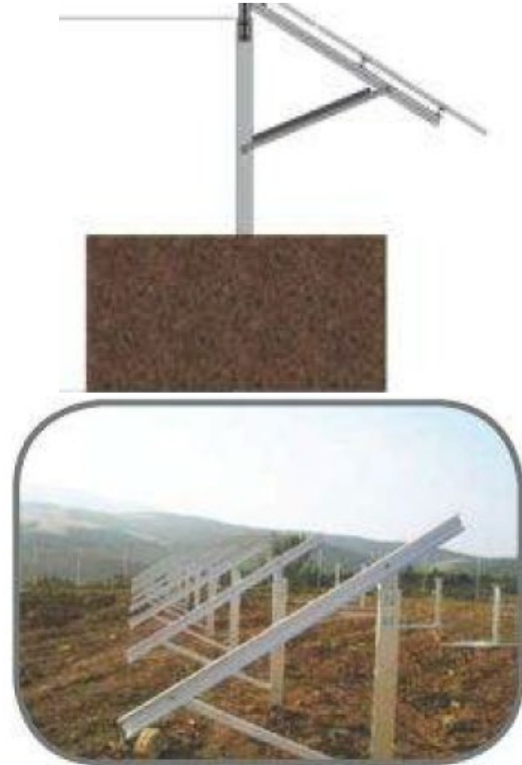
Εικόνα 6-9: Σχέδιο πασσαλόμπτυξης Βάσης φωτοβολταϊκών πινάκων
