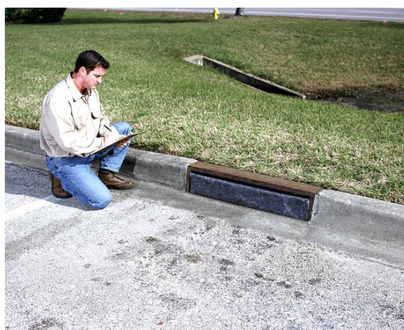
Εικόνα 7.1 Σύστημα συλλογής ελαιωδών αποβλήτων
