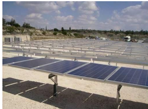
Φωτογραφία 6. Ενδεικτική θεμελίωση Φωτοβολταϊκού Πάρκου με πασσαλόμνηξη.
