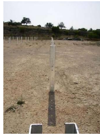
Φωτογραφία 4. Ενδεικτική θεμελίωση Φωτοβολταϊκού Πάρκου με πασσαλόμνηξη.
