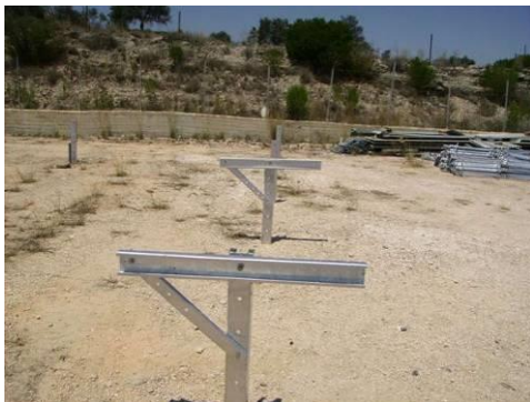
Φωτογραφία 5. Ενδεικτική θεμελίωση Φωτοβολταϊκού Πάρκου με πασσαλόμνηξη.
