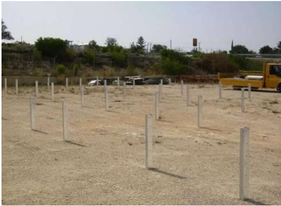
Φωτογραφία 3. Ενδεικτική θεμελίωση Φωτοβολταϊκού Πάρκου με πασσαλόμνηξη.
