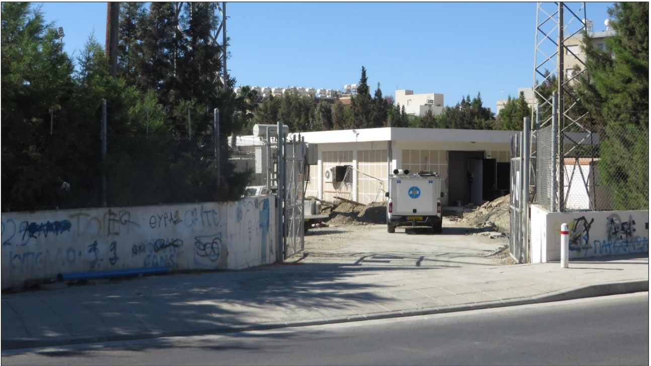
Φωτογραφία 7.24: Κατασκευαστικά έργα ΑΗΚ.
