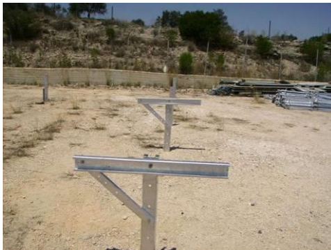
Φωτογραφία 5. Ενδεικτική θεμελίωση Φωτοβολταϊκού Πάρκου με πασσαλόμψηξη.
