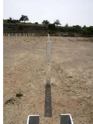
Φωτογραφία 4. Ενδεικτική θεμελίωση Φωτοβολταϊκού Πάρκου με πασσαλόμψηξη.
