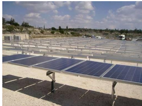
Φωτογραφία 6. Ενδεικτική θεμελίωση Φωτοβολταϊκού Πάρκου με πασσαλόμψηξη.
