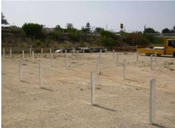
Φωτογραφία 3. Ενδεικτική θεμελίωση Φωτοβολταϊκού Πάρκου με πασσαλόμψηξη.
