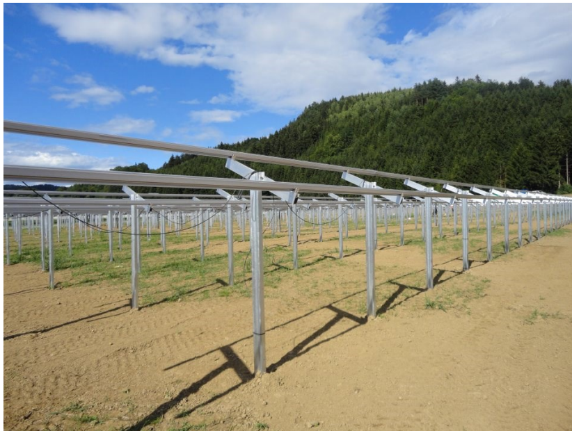
Εικόνα 2: Τυπική διάταξη τοποθέτησης ΦΒ πλαισίων με εδαφόμπτυξη 12
