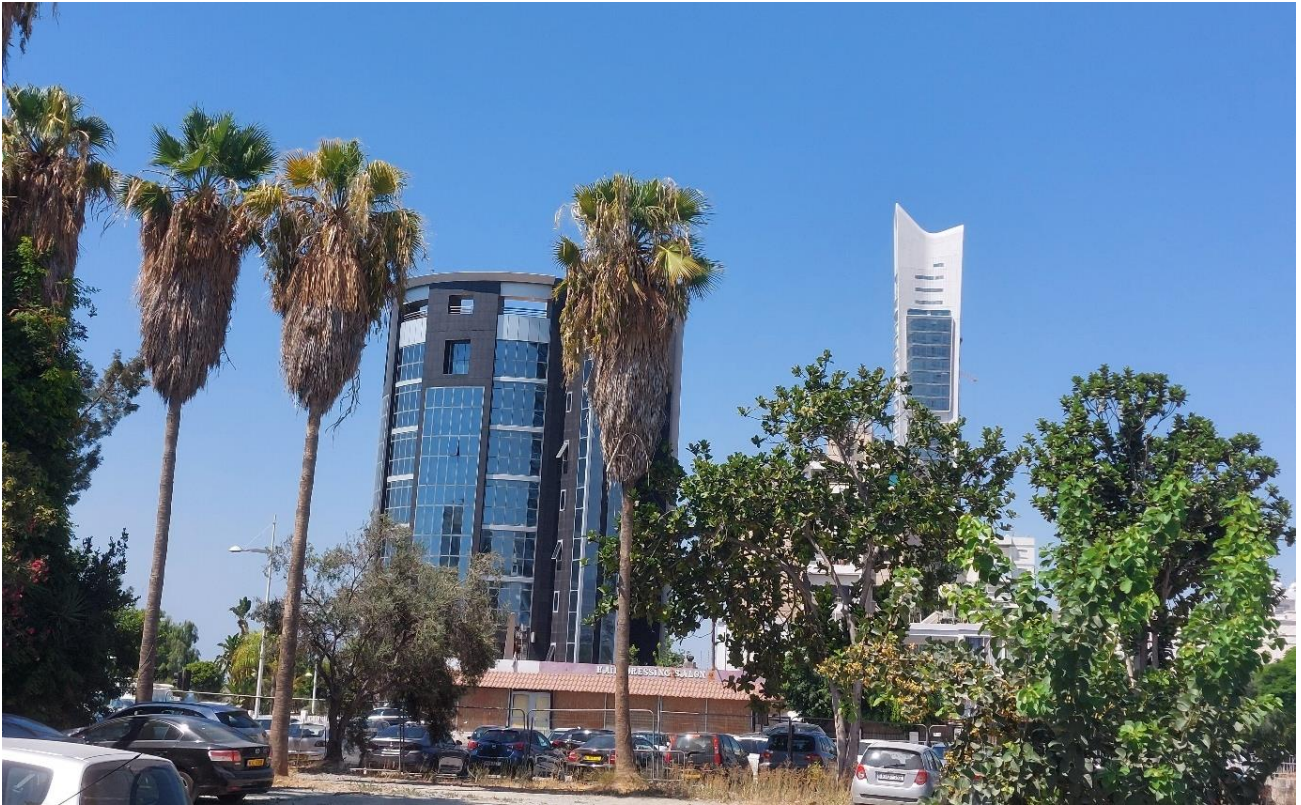
Φωτογραφία 7.38: Άλλα ψηλά κτήρια στην περιοχή δυτικά του υπό μελέτη τεμαχίου.
