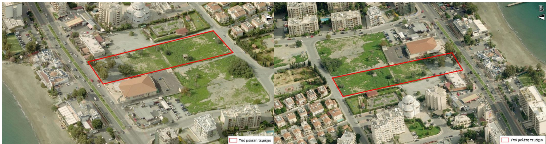
Φωτογραφία 7.2: Αεροφωτογραφίες του υπό μελέτη τεμαχίου – ανατολική όψη (αριστερά εικόνα) και δυτική όψη (δεξιά εικόνα).
