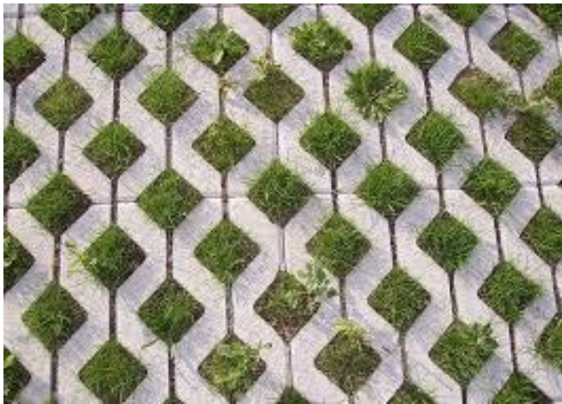
Εικόνα 8.1: Χρήση διαπερατών υλικών για επίστρωση εξωτερικών χώρων
