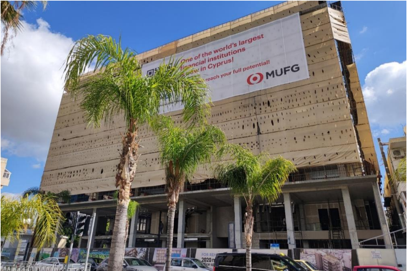
Φωτογραφία 7.17: Υπό κατασκευή Έργο ανατολικά του υπό μελέτη τεμαχίου.
