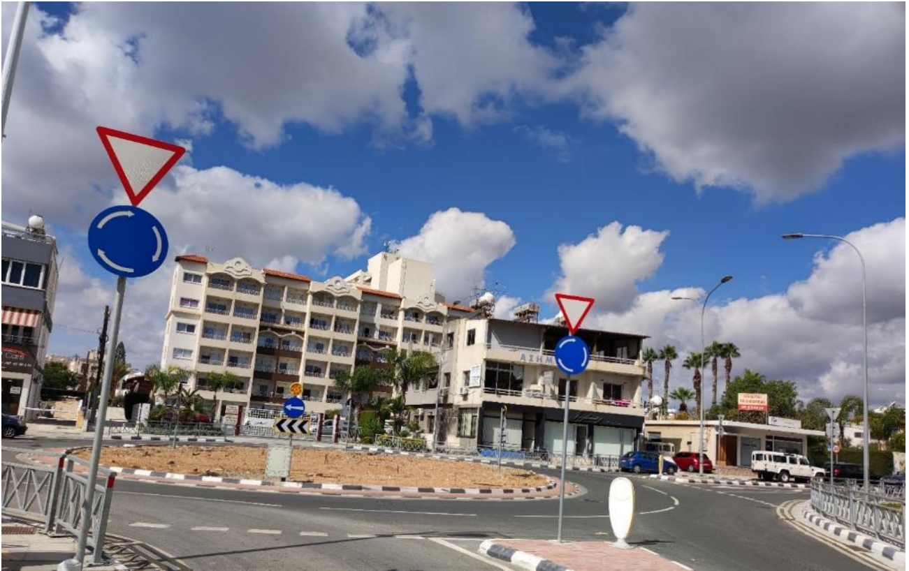
Φωτογραφία 7.6: Κυκλικός κόμβος επί της οδού Χριστάκη Κρανού.
