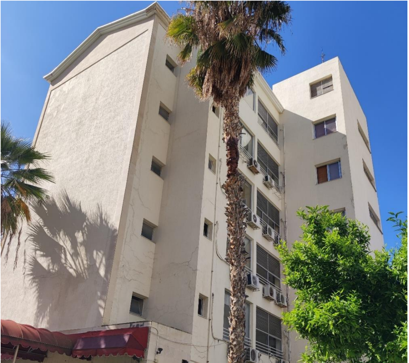
Φωτογραφία 7.13: Νοτιοανατολική όψη του υπό μελέτη τεμαχίου.
