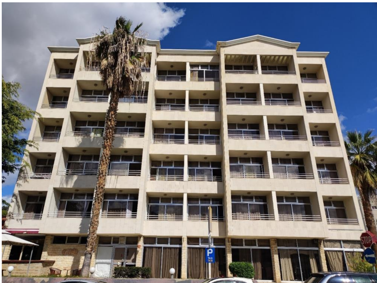
Φωτογραφία 7.10: Νότια όψη του υπό μελέτη τεμαχίου.
