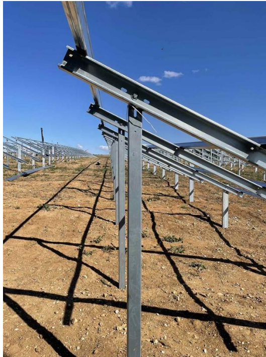
Εικόνα 7. Ενδεικτική φωτογραφία πασσαλόμπληξης (Photo: https://www.edrasol.gr/ , access 2023)
